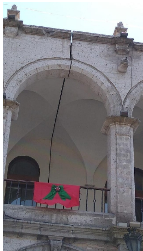
Figura 6.- Efectos del sismo de Arequipa del 16 de diciembre, 2020: caída de techos de tipo cielo raso, desprendimientos de estuques y desplazamientos en juntas de paredes (Fuente: redes sociales).
