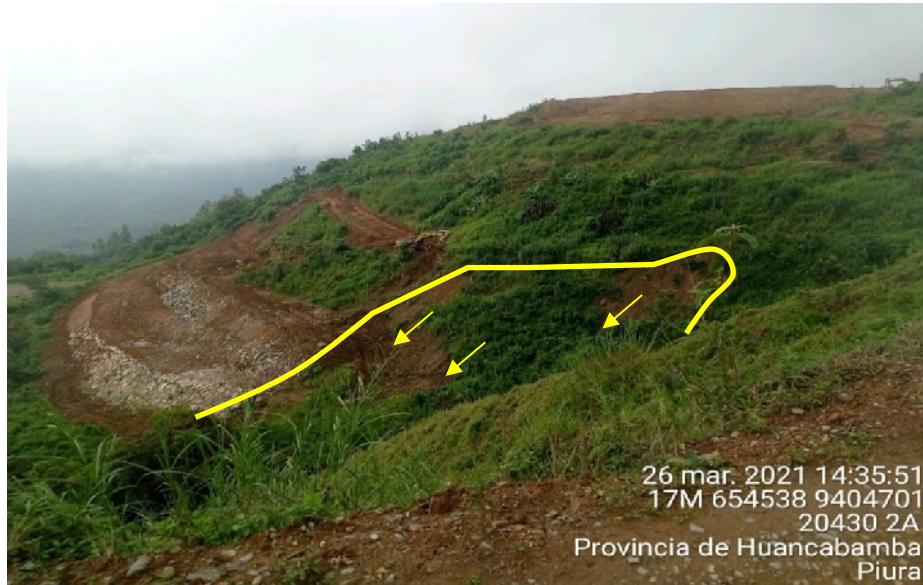
Figura 29: Derrumbe identificado en las inmediaciones del DME-01
