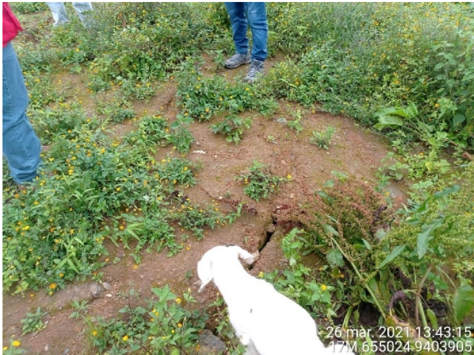
Figura 27: Grietas en la parte superior del DME-04
