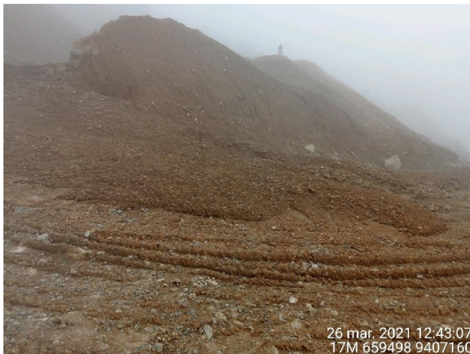
Figura 25: Flujo de detritos que afectó el DME-05
