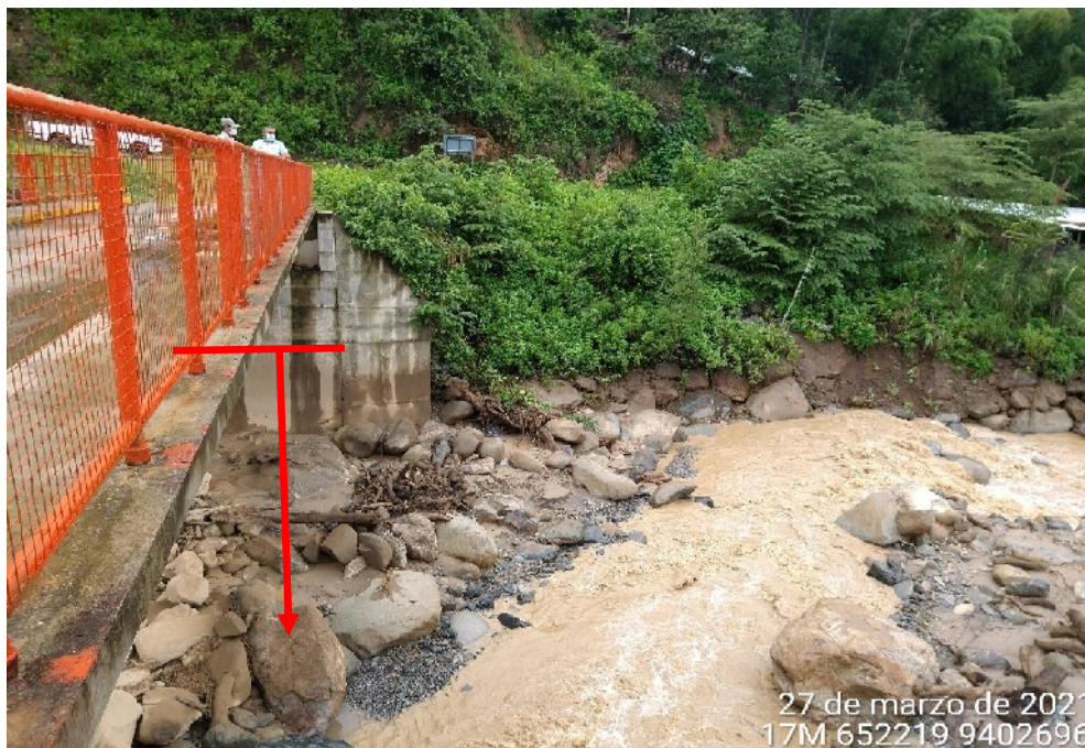
Figura 16: En las inmediaciones del sector Huabal la altura del flujo disminuye hasta 1.20 m. con respecto al cauce de la quebrada
