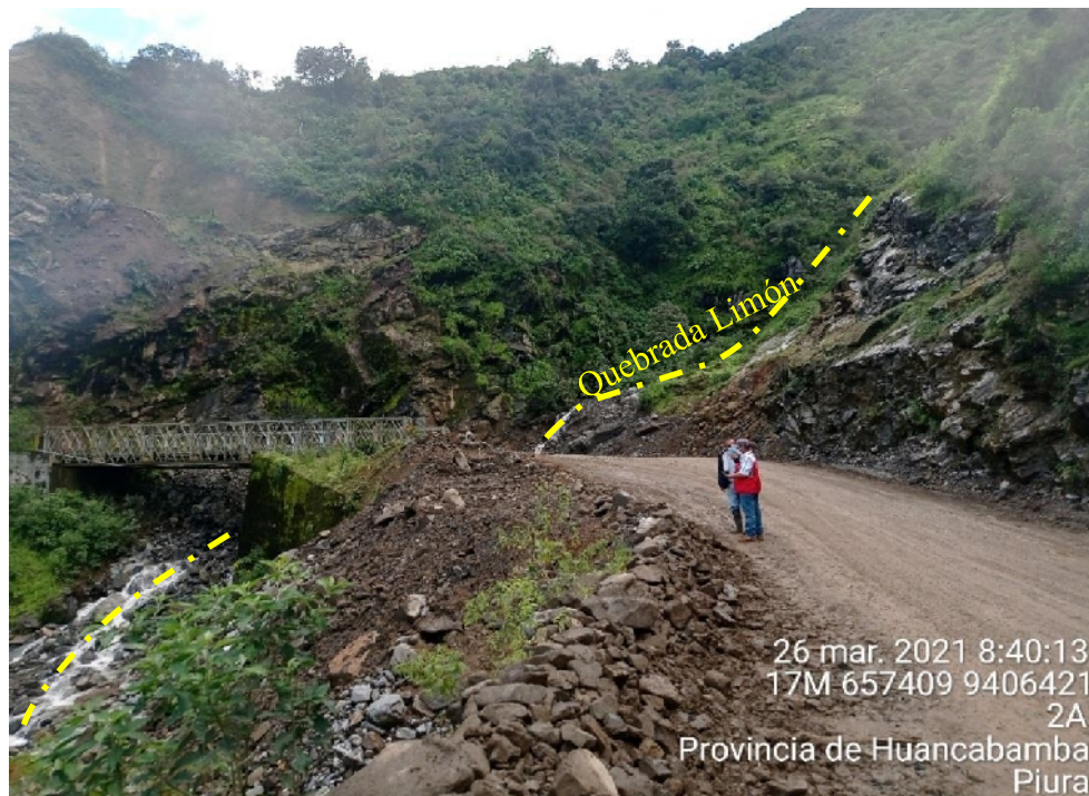
Figura 17: Quebrada Limón y ubicación del puente Fierro en las inmediaciones de la vía Canchaque – Huancabamba. Zona susceptible a la ocurrencia de flujos de detritos
