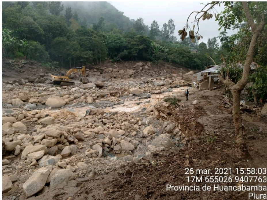
Figura 11: Vivienda colapsada en el margen derecho de la quebrada Pusmalca. Obsérvese el tipo de materiales transportados por el flujo
