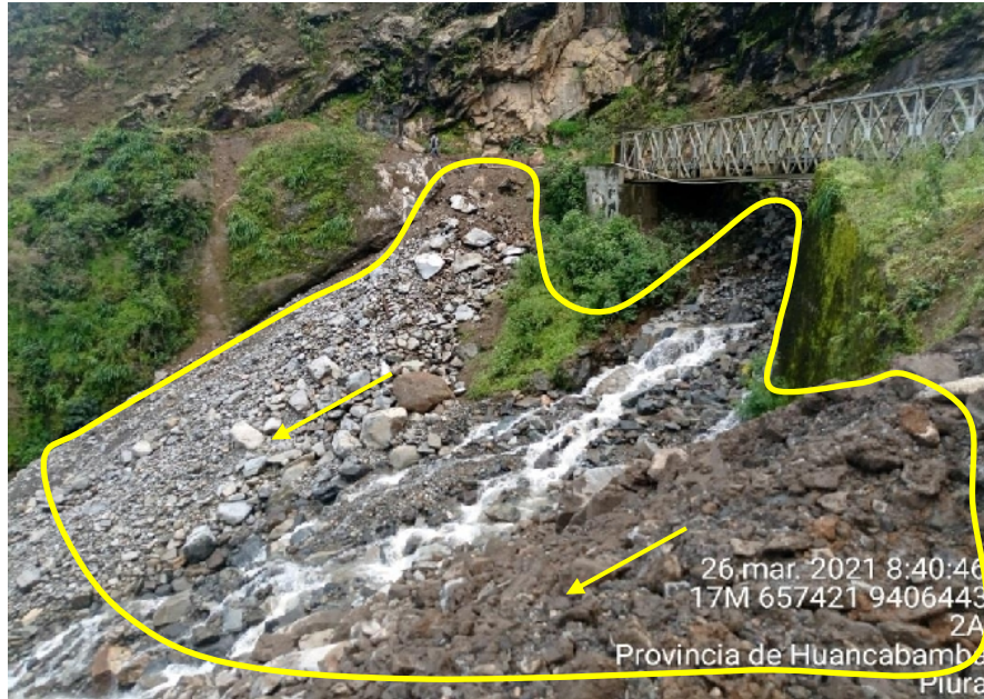
Figura 18: Materiales inestables en el cauce de la quebrada Limón
