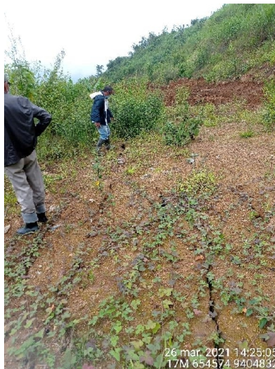
Figura 30: Grietas contiguas a zona de botadero DME-01
