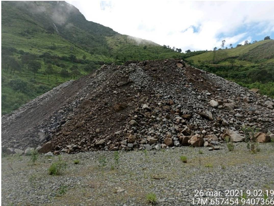
Figura 26: Materiales heterogéneos dispuestos sobre el DME – 09, que no muestra procesos de inestabilidad.
