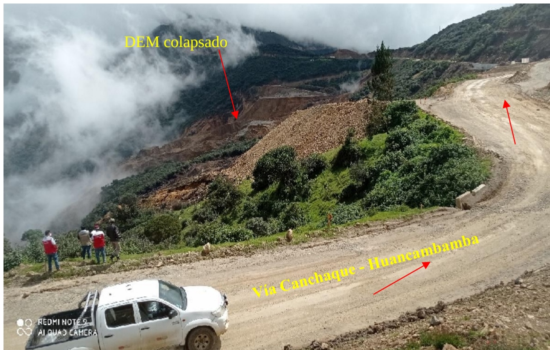
Figura 4: Botadero DME-111 colapsado en vía Canchaque – Huancabamba. Sus materiales, aparentemente se han desplazado hacia la quebrada Pusmalca
