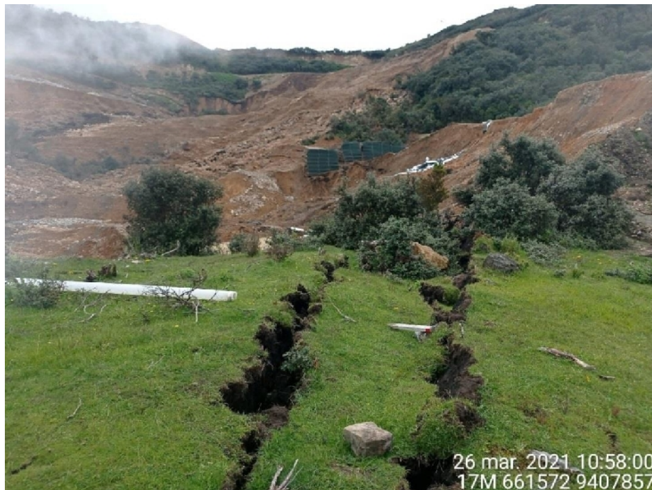
Figura 21: Grietas ubicadas al costado del DME-111
