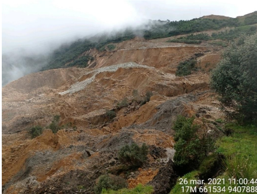
Figura 6: Botadero colapsado debido a la presencia de suelos saturados por la ocurrencia de precipitaciones pluviales
