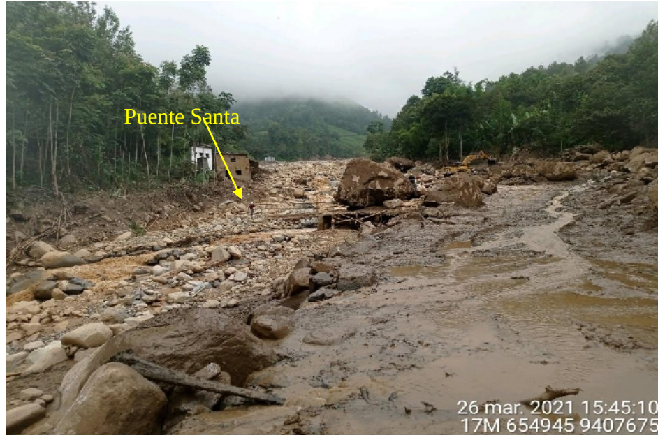
Figura 10: Quebrada Pusmalca en las inmediaciones del sector Lagunillas del Chorro Blanco. Aquí los flujos alcanzaron alturas superiores a los 5 m en el cauce produciendo el colapso del puente Santa Rosa
