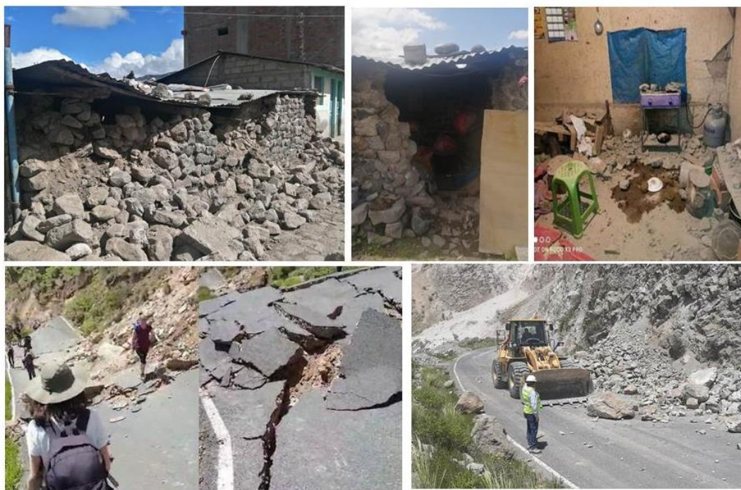
Figura 5: Daños en viviendas de adobe en la localidad de Maca y alrededores con escenarios donde se han producido la caída de piedras y tierra afectando a las carreteras.
