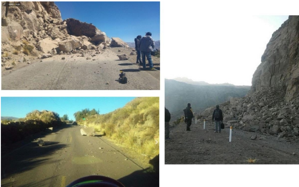
Figura 8: Principales deslizamientos de tierra y piedras en varios tramos de las carreteras de Arequipa a Chivay, Maca y Huambo (Fuente: RPP, INDECI, Bomberos de Arequipa)
