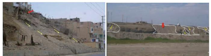
Figura 2: Zona de alta susceptibilidad a la ocurrencia de derrumbes. Figura 3: Derrumbes en taludes conformados por depósitos aluviales. Ellos se encuentran en el límite de los distritos de Caleta Carquin y Huacho.
