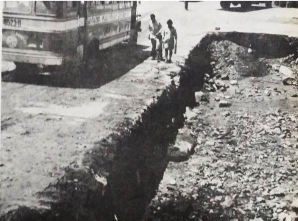
Arequipa, 08/03/1972. En la imagen una extensión de 40 m de largo por 12 de ancho a destruido la activación de la torrentera de Mariano Melgar a la altura del colegio LA Gran Unidad Escolar (Diario El Pueblo)
