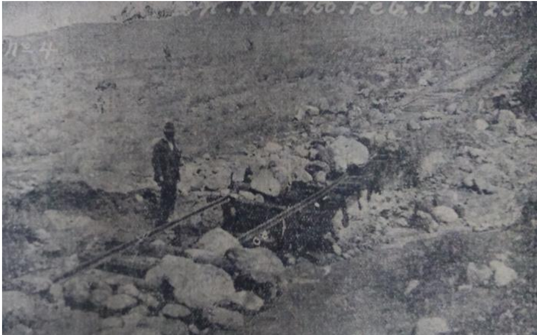
Arequipa, 20/02/1925. Daños en el km 16 de la vía férrea de Arequipa-Puno (Diario El Deber)
