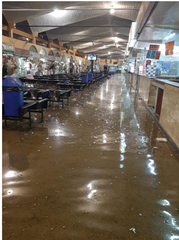
Arequipa 25/02/2020. Terminal terrestre ubicado en la margen izquierda de la torrentera de Mariano Melgar, a la altura de la intersección de la avenida Los Incas con la avenida Andrés Avelino Cáceres, fue inundado por desborde de las aguas de la torrentera. (peru21.pe)
