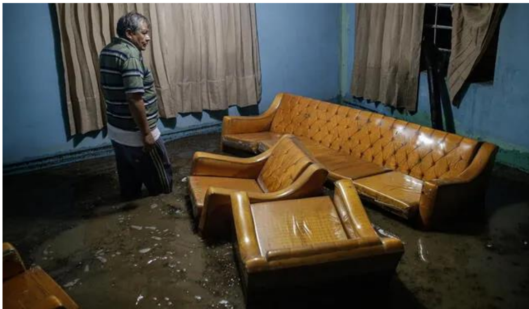
Arequipa 26/01/2023. Vivienda inundada en el distrito de Jacobo Hunter (larepublica.pe)
