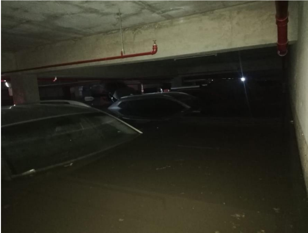
Figura 20.- Más de 20 vehículos afectados en el condominio Alegra en el distrito de José Luis Bustamante y Rivero por rebalse de acequia por lluvias constantes (elbuho.pe, 20/02/2020).
