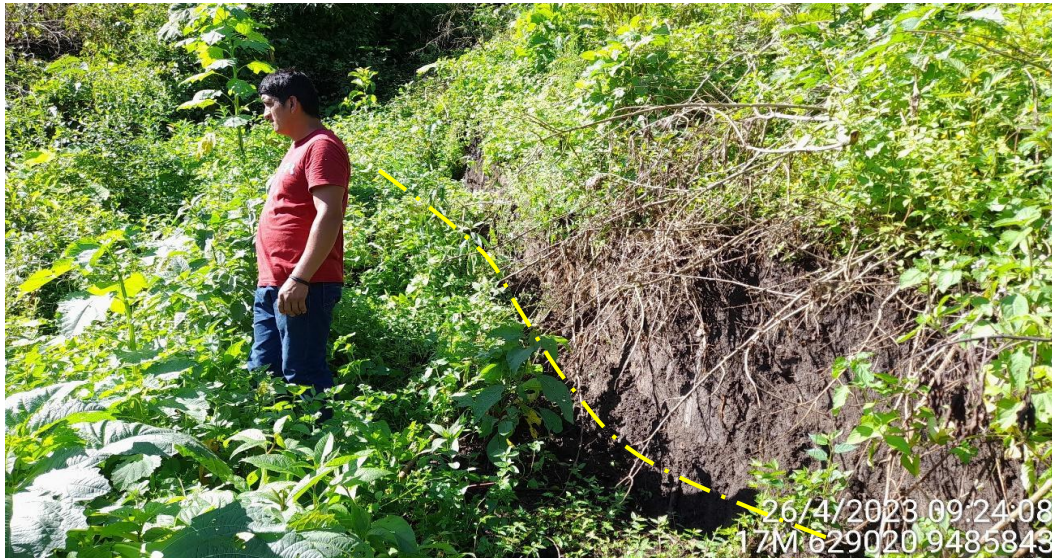
Figura 41.- Zona de arranque en ladera inestable, reconocida en la parte superior de la institución educativa Los Girasoles
