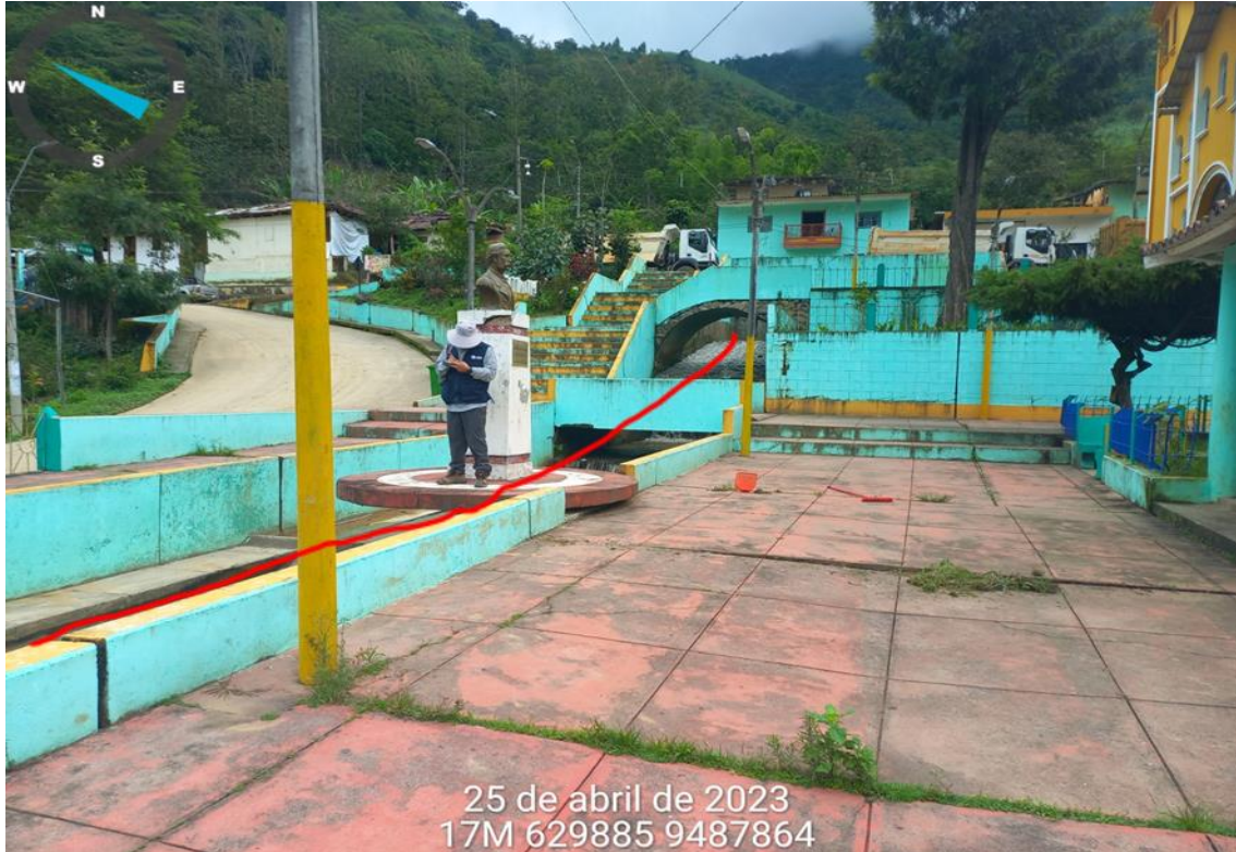
Figura 5.- Quebrada Loja (línea roja) que ha sido encausada y discurre contigua a la plaza de Montero
