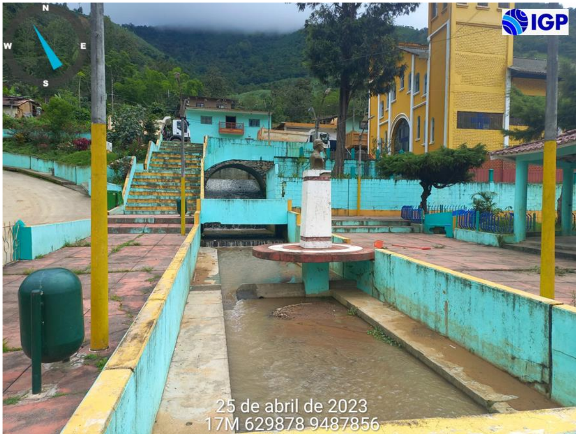
Figura 33.- Encauzamiento de la quebrada La Loja en las inmediaciones de la plaza de Montero que podría ser afectada por flujos de lodo
