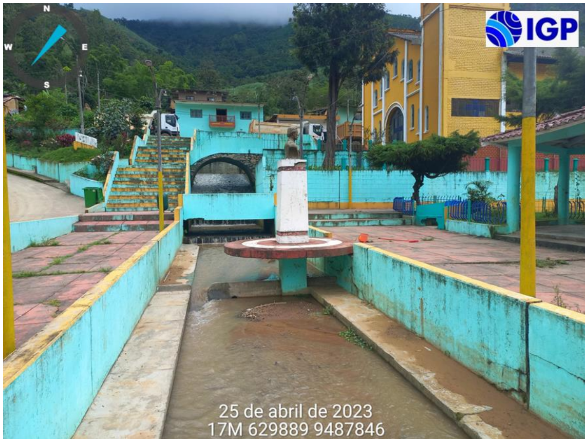
Figura 19.- Depósito aluvial reciente conformado por arenas y limos depositados sobre el cauce de la quebrada Loja, en las inmediaciones del parque de Montero
