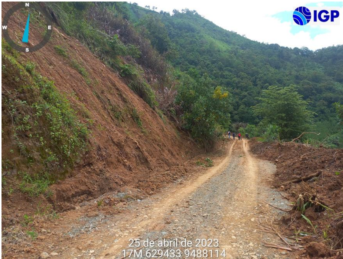
Figura 20.- Depósito coluvial conformado por materiales sueltos (arenas, limos y arcillas) que han sido depositados sobre la ladera y parte de la vía de acceso hacia quebrada La Loja
