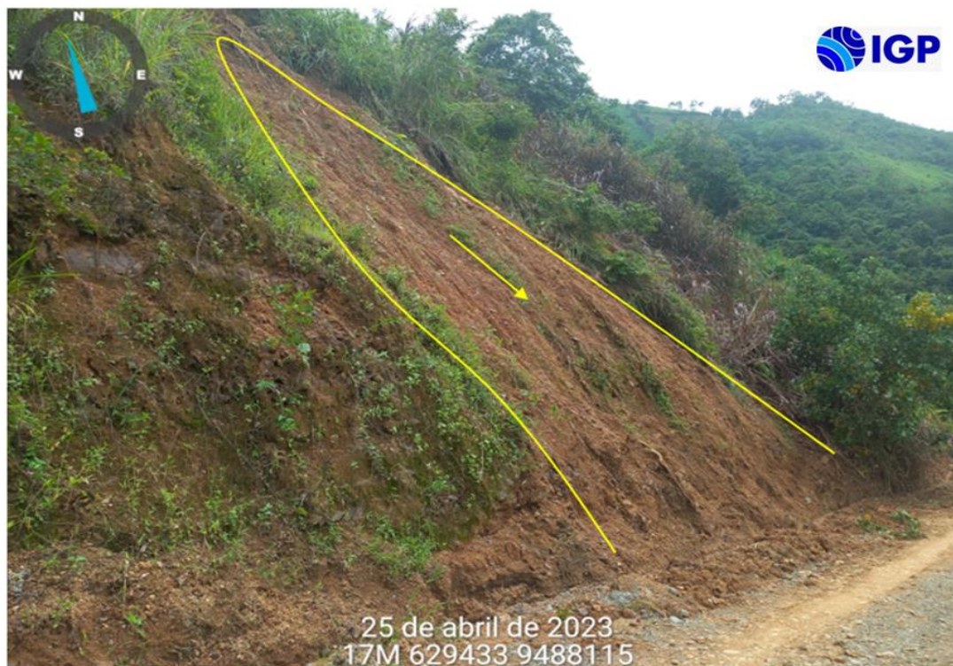
Figura 30.- Derrumbe (debajo de línea amarilla) generado en el sector Z debido a la ocurrencia de precipitaciones pluviales intensas que afectó la vía Montero – Santa Cruz y caseríos aledaños
