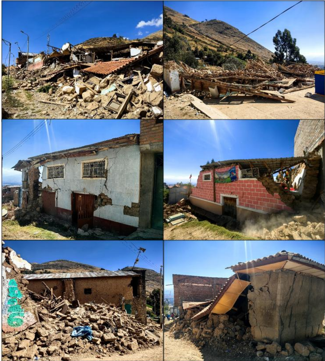
Figura 30.- Viviendas de adobe colapsadas en el entorno de la plaza de Pumpunya
