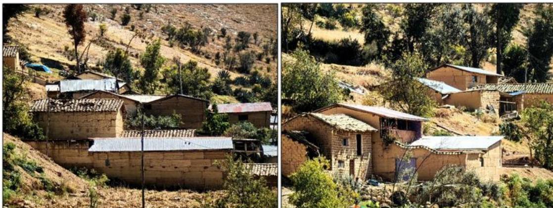
Figura 34.- Viviendas de adobe cerca al sector inferior de Pumpunya sin daños graves
