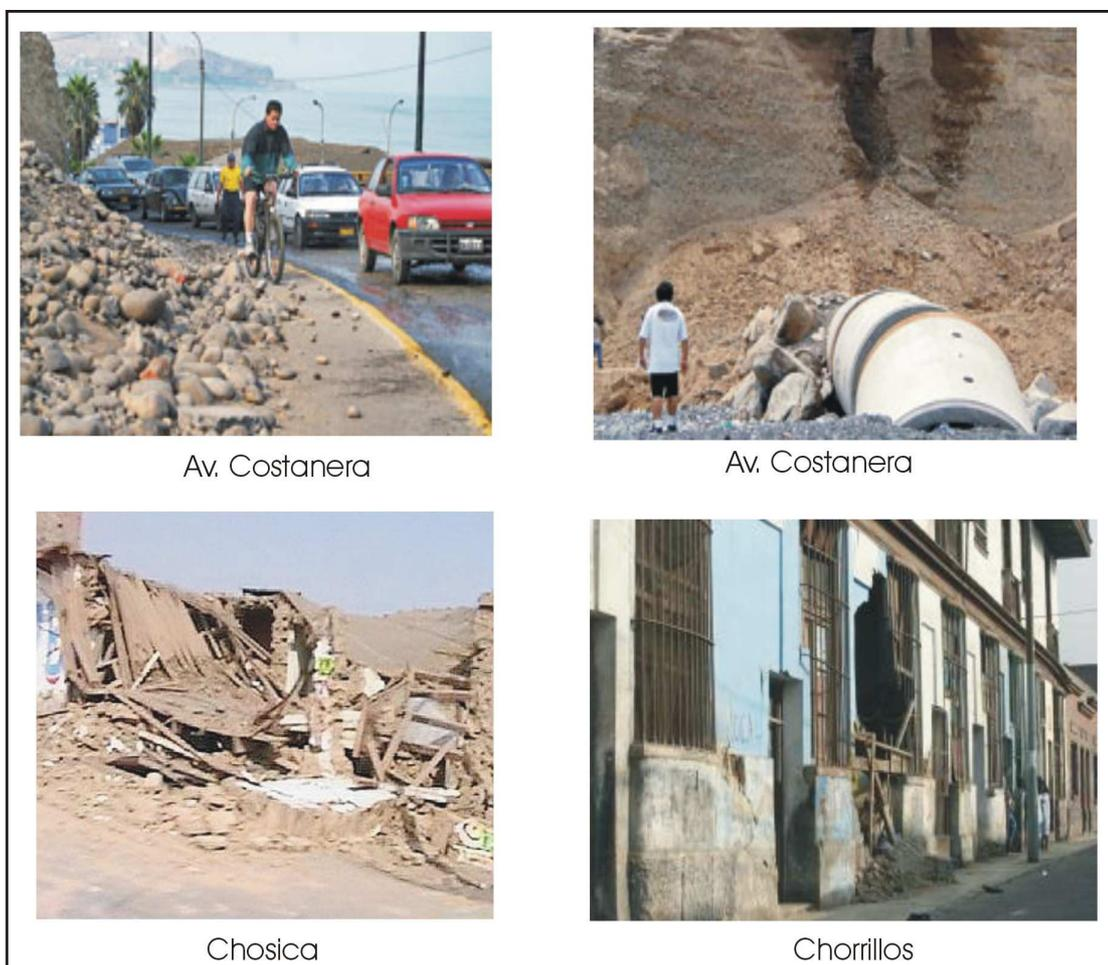
Figura 3.- Desprendimientos de rocas y tierra en la Av. Costanera, y casas desplomadas y dañadas en Chosica y Chorrillos.
