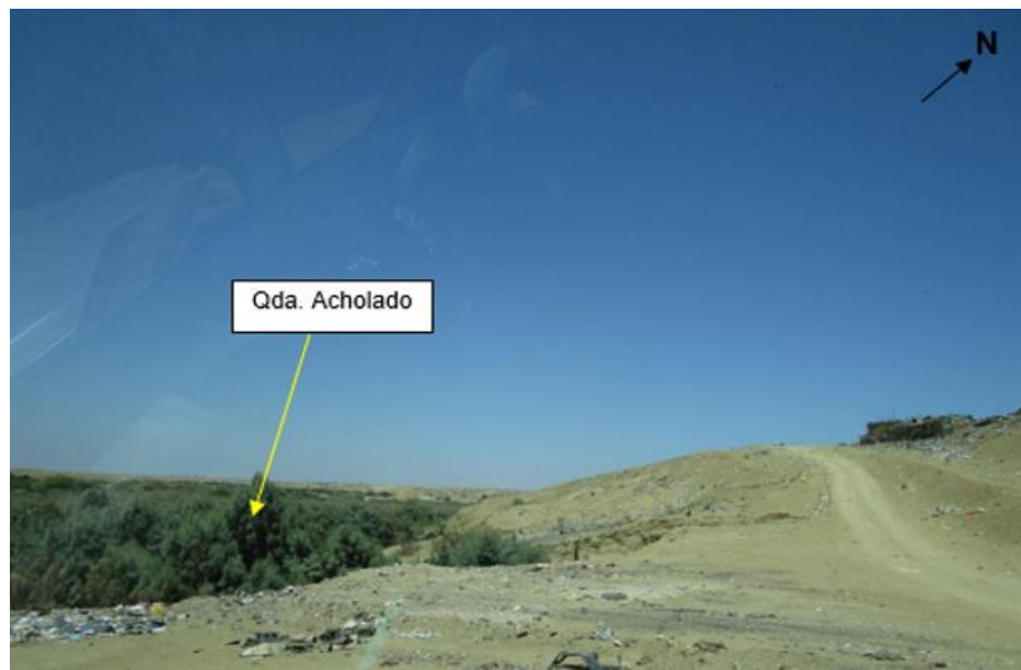
Figura 7: Lecho aluvial de la quebrada Acholado.
