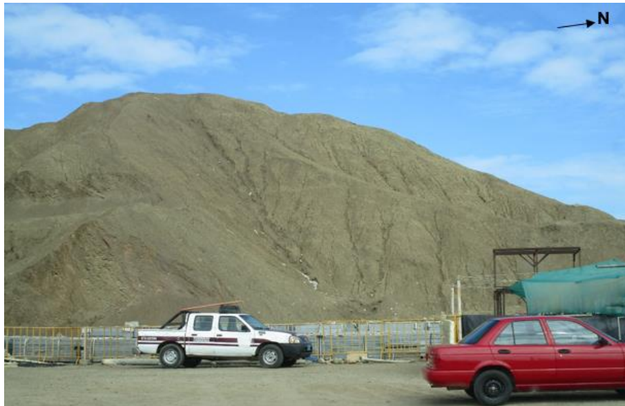
Figura 36: Cárcavas en ladera, zona del ex campo ferial-Talara.
