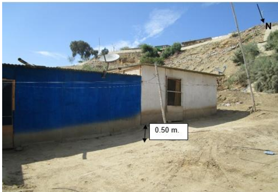
Figura 31: Zona afectada por activación de escorrentías.
