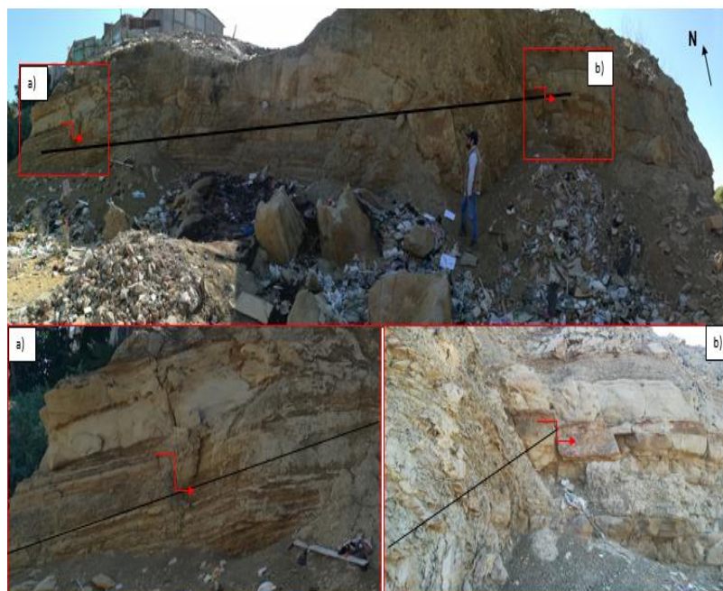
Figura 22: Zona de bloques de areniscas desplazados por la actividad de la falla El Acholado, en la parte superior de estos estratos se ubica el AA.HH. Los Robles.
