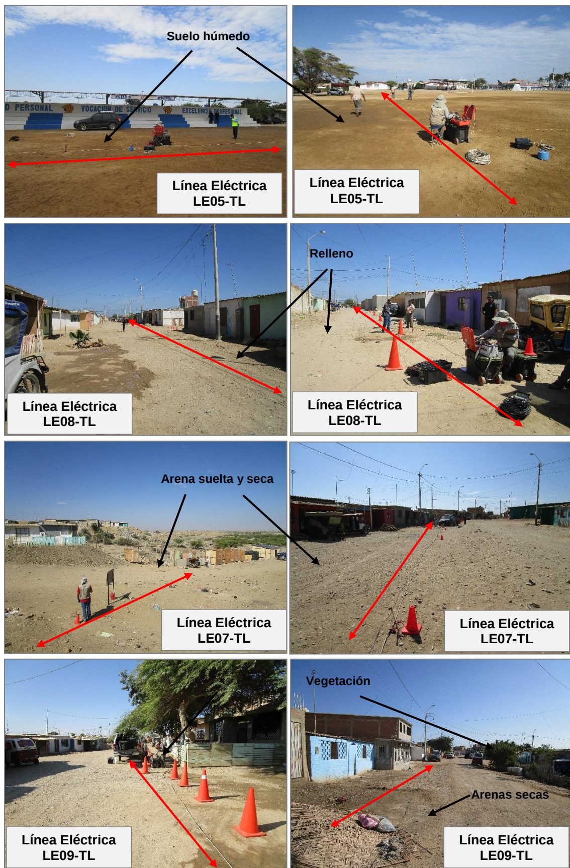
Figura 17: Vista de la línea eléctrica LE05-TL, LE07-TL, LE08-TL y LE09-TL.
