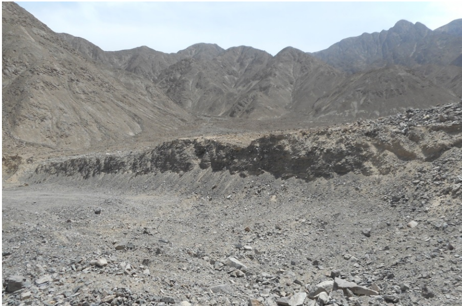
Figura 15: Se han realizado cortes transversales para la construcción de muros de contención, en la cual se aprecian espesores de hasta 7 m.
