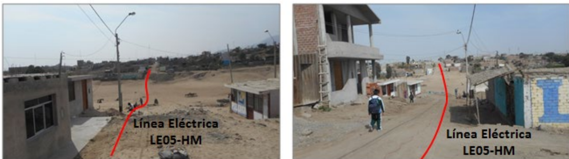
Figura 24: Características superficiales de LE05-HM, el terreno es una depresión.
