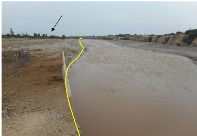
Figura 9: La llanura de inundación en Bernalles se encuentra a menos de 1.5 m de desnivel con respecto al cauce del río Pisco.
