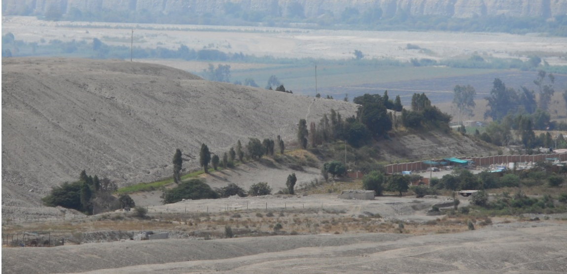
Figura 28: La quebrada la Meda es el principal canal por donde descienden los flujos de detritos.
