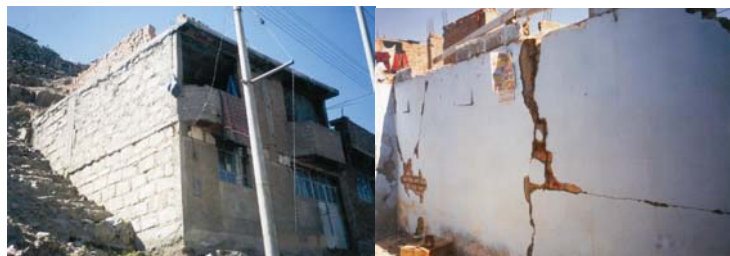
Fig.14. Izquierda, vivienda ubicado cerca de la estación HUAC. Derecha, vivienda ubicado cerca de la estación CRIS
