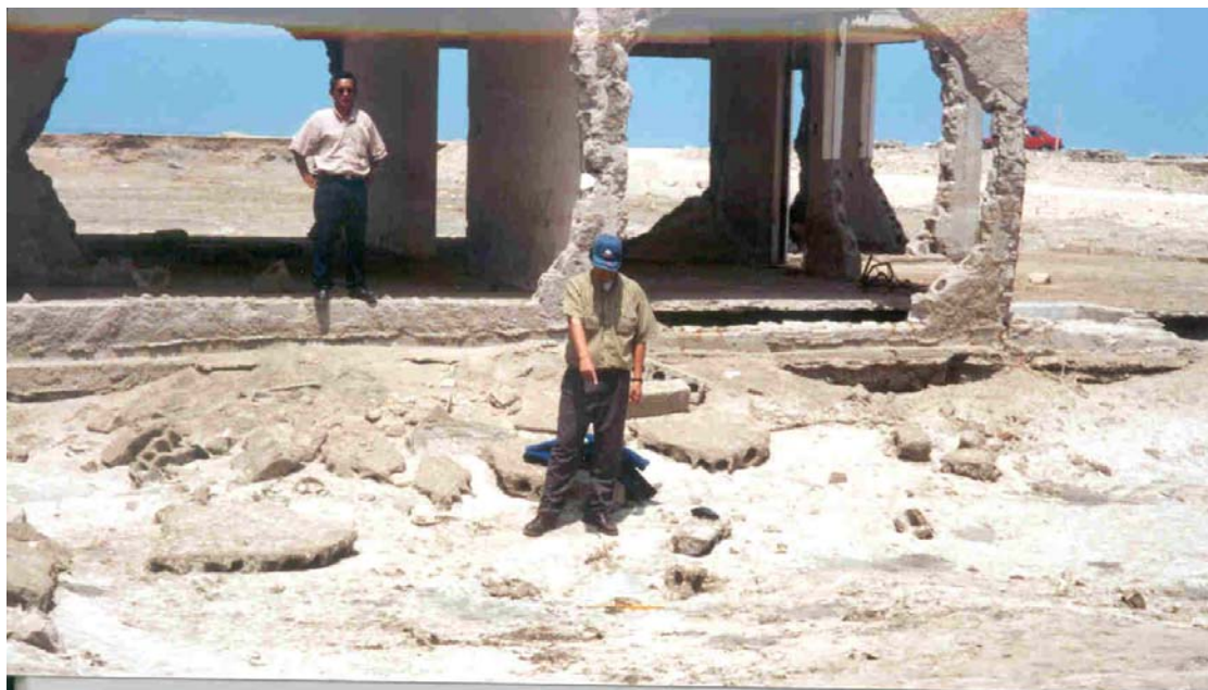
Figura 7. Volúmenes de arena por efecto de licuación de suelos formados posterior al sismo.
