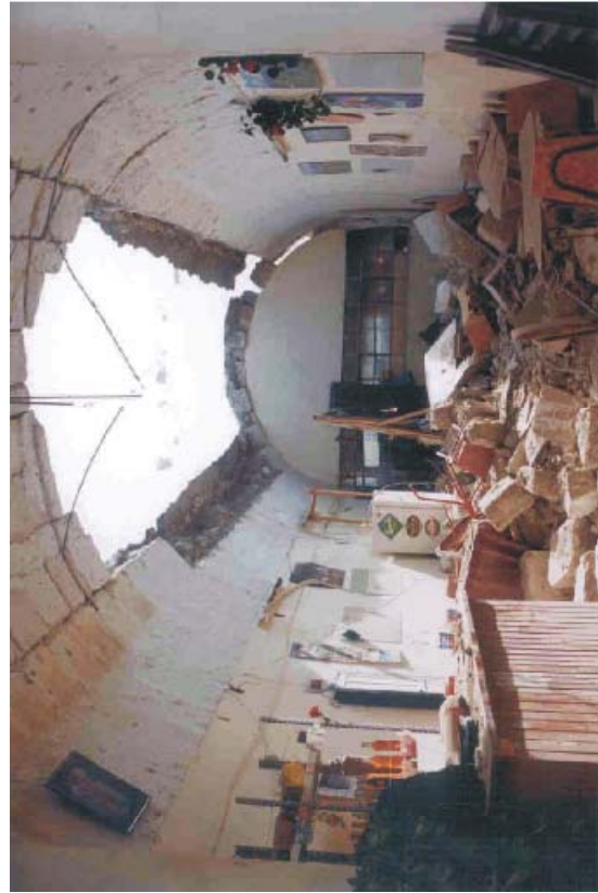
Imágenes de Viviendas del tipo B ubicadas en el Mercado de Arequipa y que sufrieron desprendimiento de cornizas. Techos característicos de viviendas de tipo B. Bóvedas con rieles presentes en el cercado de Arequipa y que fallan por falta de refuerzo transversal y la diferencia de rigidez entre el techo y los bloques de sillar.
