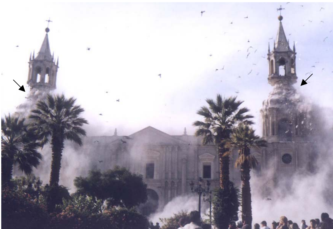
Foto 7.- Catedral de Arequipa. Desplome de la parte superior de su torre.
