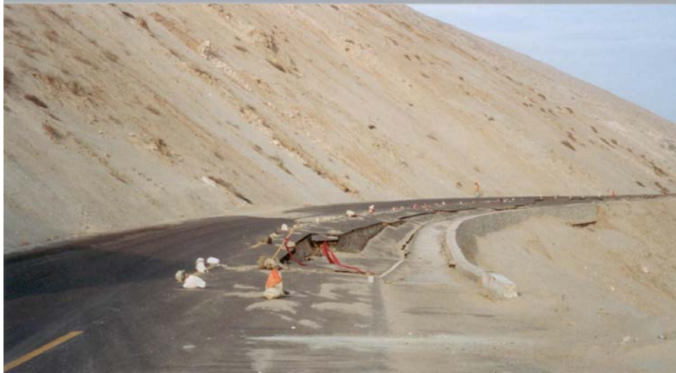
Figura 2. Tramo Atico-Ocoña (secor cerro de Arena). Desplazamientos de aspersiones eolicas un tramo de la Panamericana Sur.
