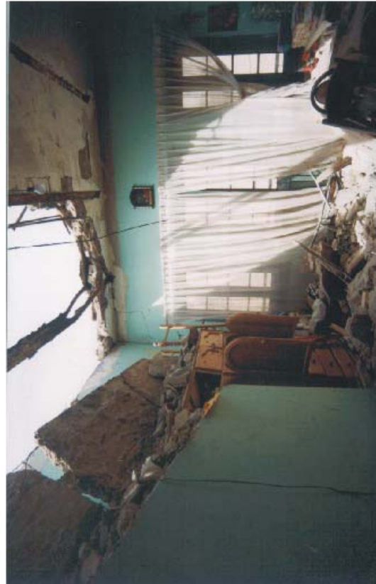
Imágenes de Viviendas del tipo B ubicadas en el Mercado de Arequipa y que sufrieron desprendimiento de cornizas. Techos característicos de viviendas de tipo B. Bóvedas con rieles presentes en el cercado de Arequipa y que fallan por falta de refuerzo transversal y la diferencia de rigidez entre el techo y los bloques de sillar.
