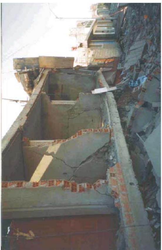
Vista frontal y lateral de una Vivienda de tipo C ubicada en la Av. El Sol, Distrito de Ciudad Nueva, Tacna. Sufrió destrucción parcial y asentamiento por problema del tipo de suelo.
