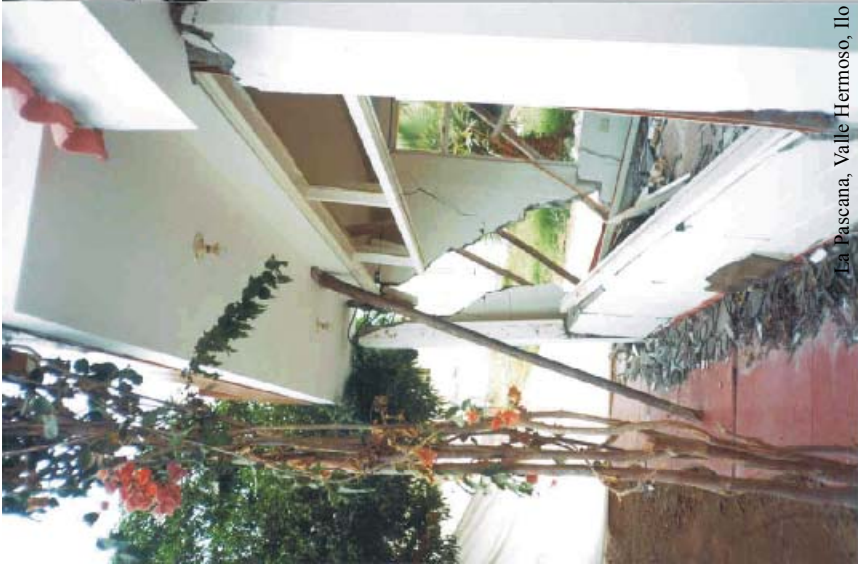
Imágenes de viviendas de tipo C ubicadas en La Pascana, Valle Hermoso, Ilo. Se observa el colapso en diversas partes de las construcciones.
