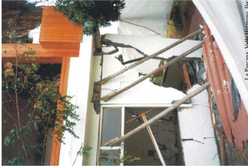
Imágenes de viviendas de tipo C ubicadas en La Pascana, Valle Hermoso, Ilo. Se observa el colapso en diversas partes de las construcciones.
