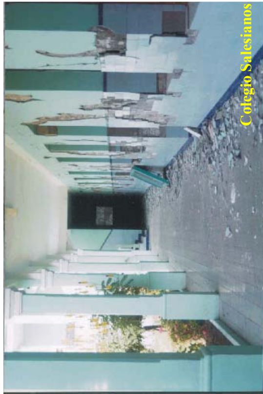
Imágenes de construcciones de tipo C. En la Universidad San Agustín se observa que la Biblioteca de Ingenierías se ha producido el colapso de la escalera y en la Facultad de Ing. Civil los muros presenta agrietamientos. El Colegio Salesianos, sufrió el desprendimiento de trozos de estuque.
