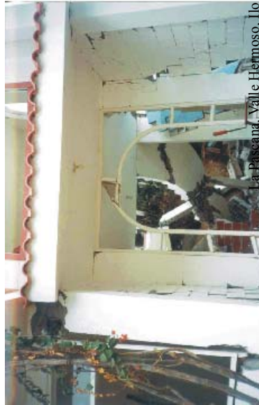
Imágenes de viviendas de tipo C ubicadas en La Pascana, Valle Hermoso, Ilo. Se observa el colapso en diversas partes de las construcciones.
