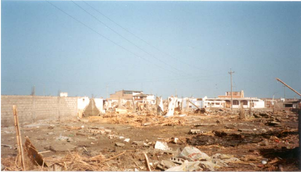
Figura 9. Balneario de La Punta, Camaná. Zona de destrucción por el tsunami del 23 de Junio de 2001.
