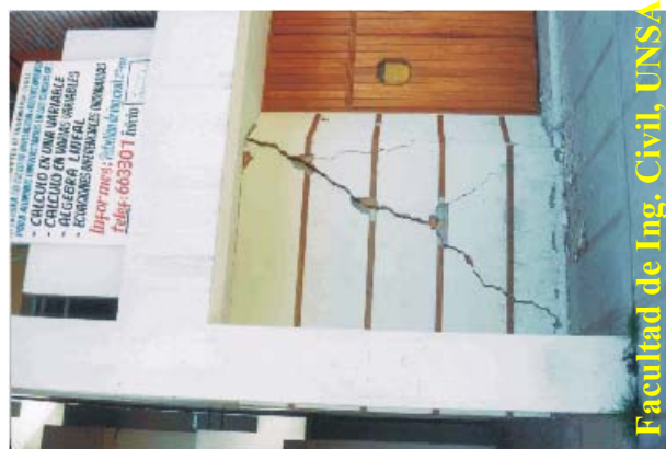
Imágenes de construcciones de tipo C. En la Universidad San Agustín se observa que la Biblioteca de Ingenierías se ha producido el colapso de la escalera y en la Facultad de Ing. Civil los muros presenta agrietamientos. El Colegio Salesianos, sufrió el desprendimiento de trozos de estuque.
