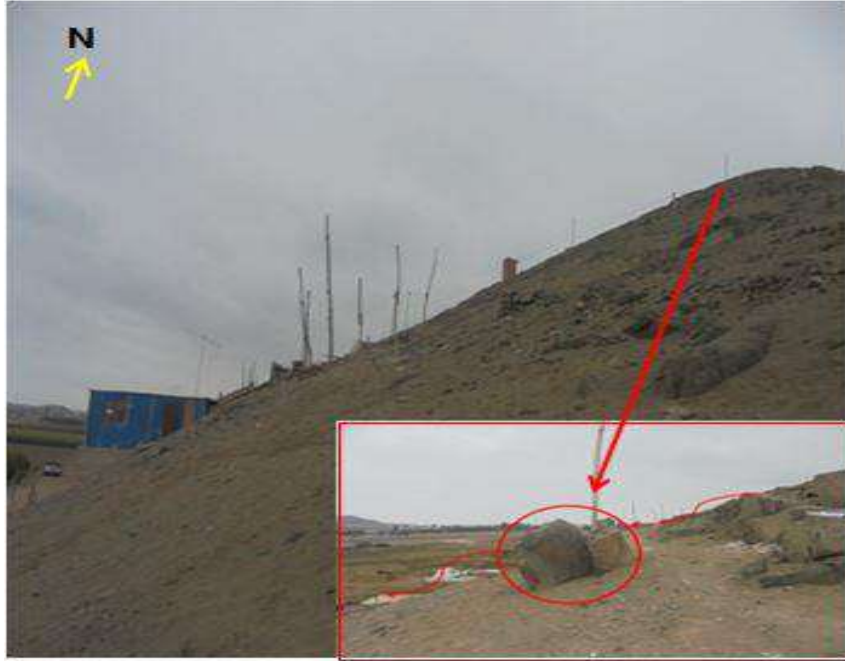
Figura 39: Caída de rocas en la ladera SO de la Loma Colina Blanca y sobre la cual se asiente la población
