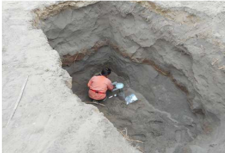
Figura 7: Ensayo de densidad del suelo a través del método del cono de arena
