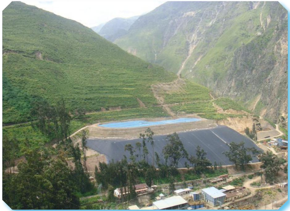
Vista de la relavera 1 y 2 de la compañía minera San Juan - Tamboraque. Se prestó consultaría para la evaluación de posibles causas de deslizamientos en la misma.
