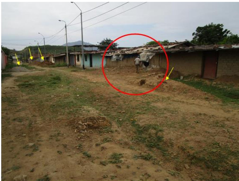
Figura 15: Vivienda del Sr. Segundo Juárez Pacherras - círculo rojo (autoconstrucción de material precario-adobe) afectada por inundaciones pluviales a causa de las precipitaciones en el año 2019 (febrero), declarada como inhabitable por la Municipalidad de Morropón (testimonio del poblador). La columna de agua de inundación según señalan pobladores llegó a 0.50 m. Las flechas amarillas indican acumulaciones de material usado para el relleno de las calles.
