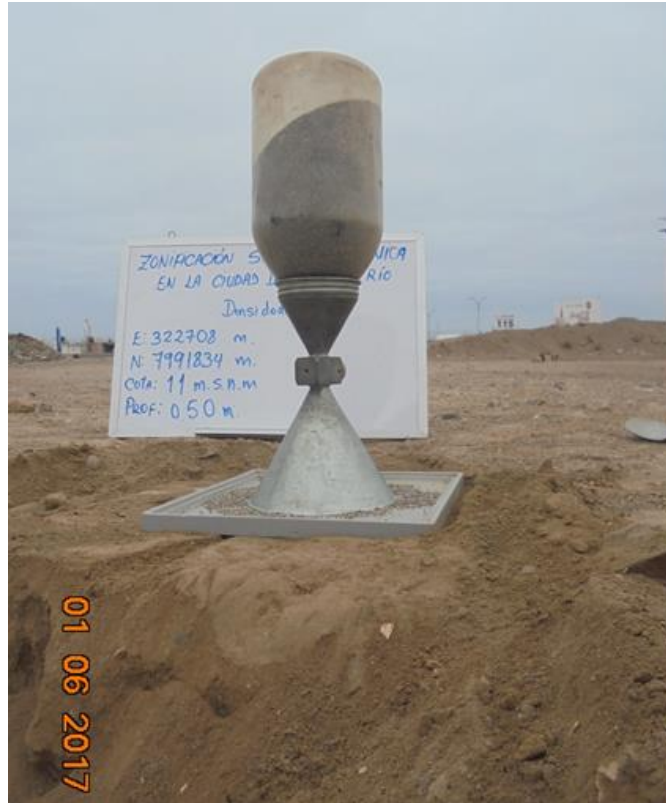
Figura 35: Ensayo de densidad del suelo in-situ en la calicata CB-02
