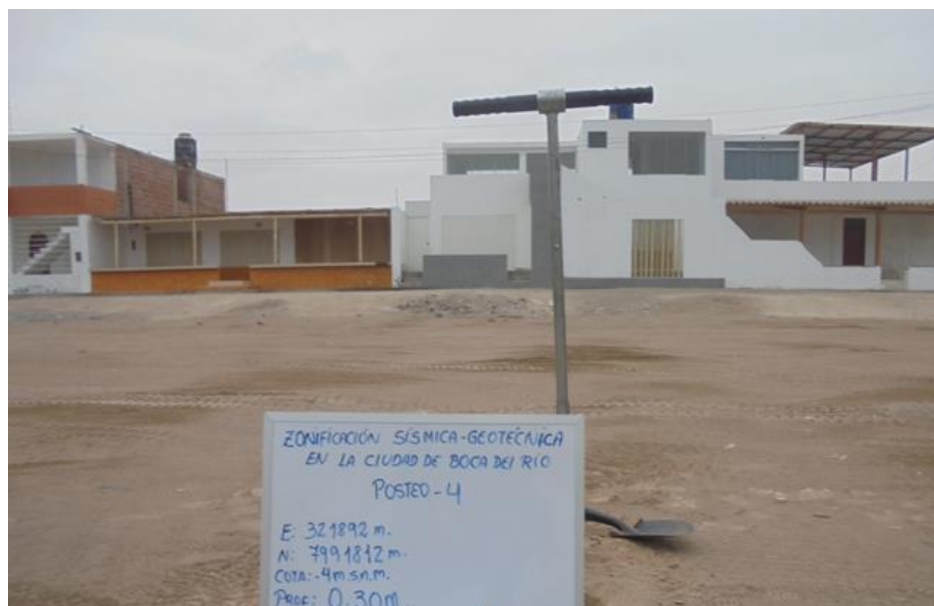
Figura 36: Ensayo con posteadora manual.
