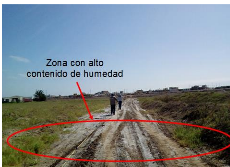
Figura 20: Suelos saturados próximo al río Sama.
