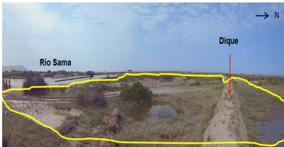
Figura 29: Zona inundada (línea color amarillo) y dique de tierra construido por la municipalidad de la localidad de Boca del Río.
