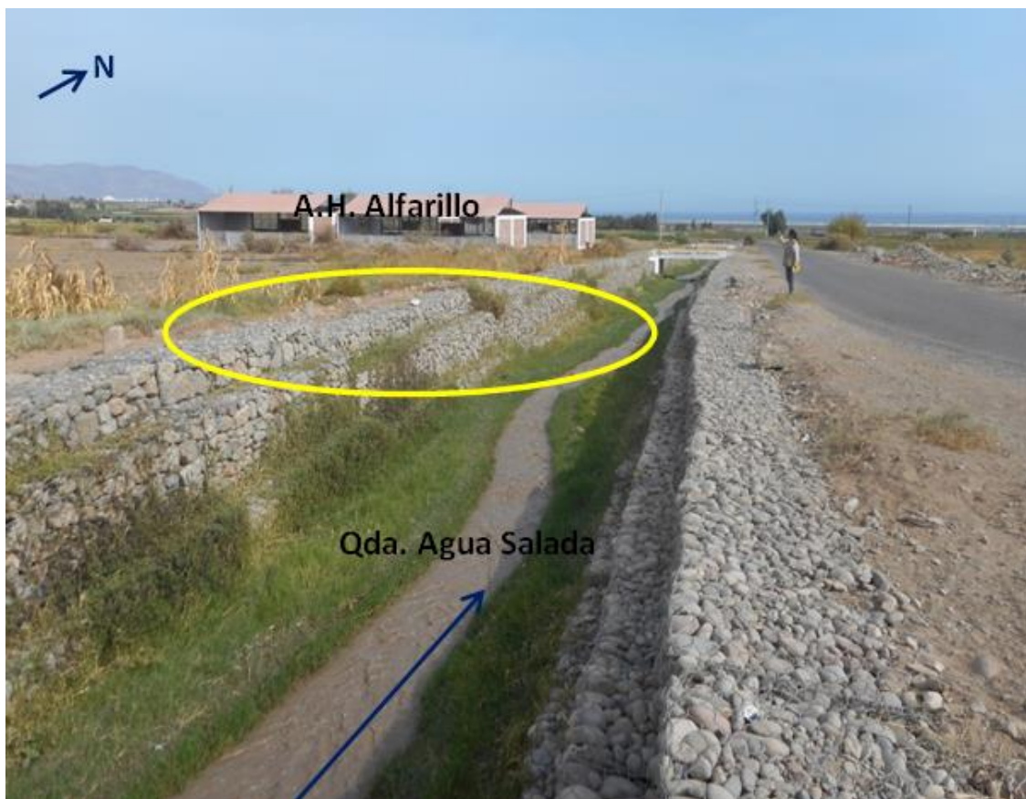
Figura 25: Gaviones en ambas márgenes de la quebrada Agua Salada a la altura del A.H. Alfarillo.
