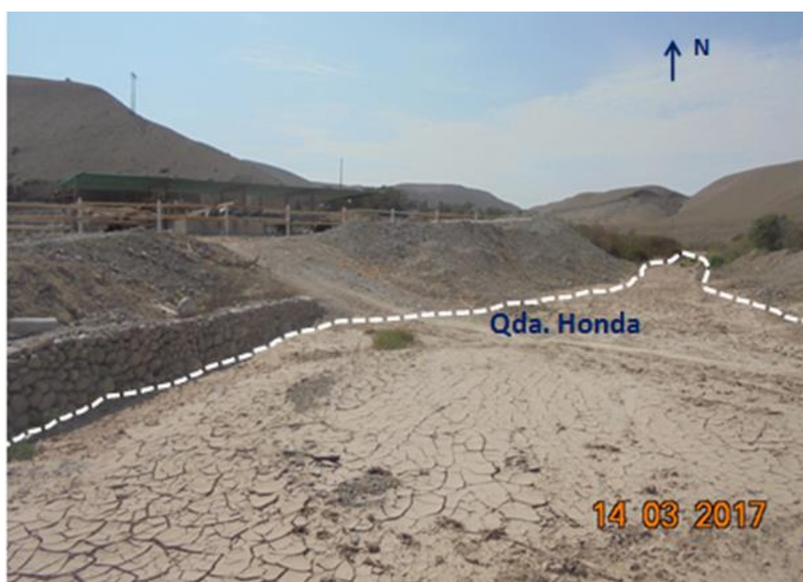
Figura 24: Flujos de detritos en la quebrada Honda, sector Sopladera.
