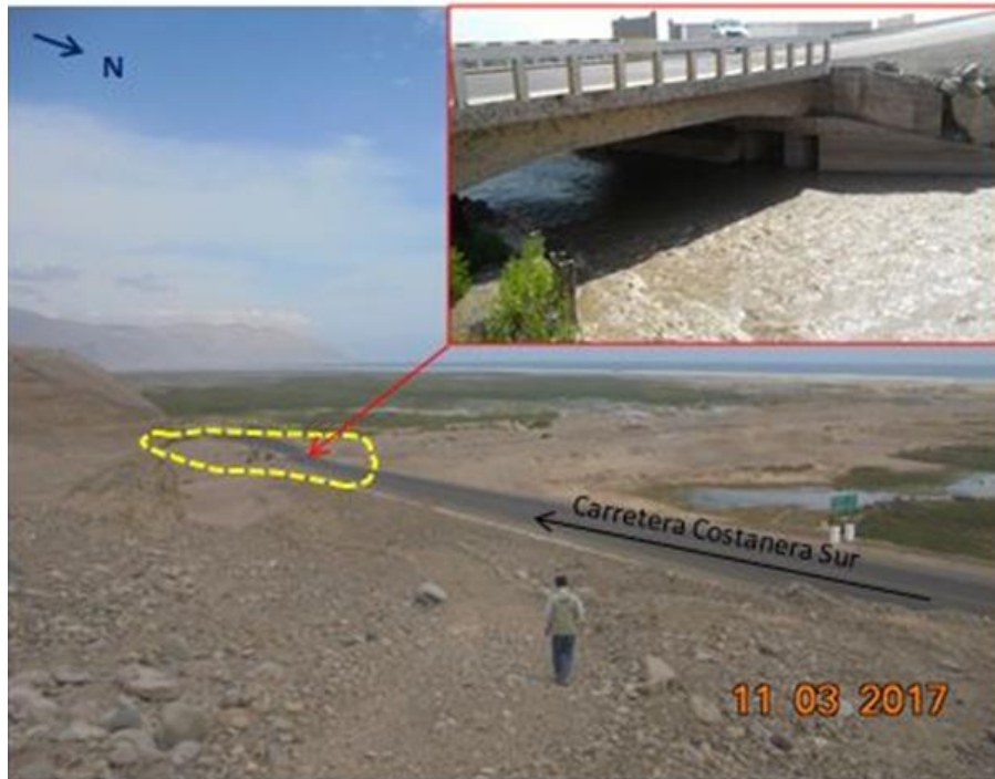
Figura 26: Zona a inundarse por desborde del río Locumba, carretera Costanera a la altura del puente Ite.
