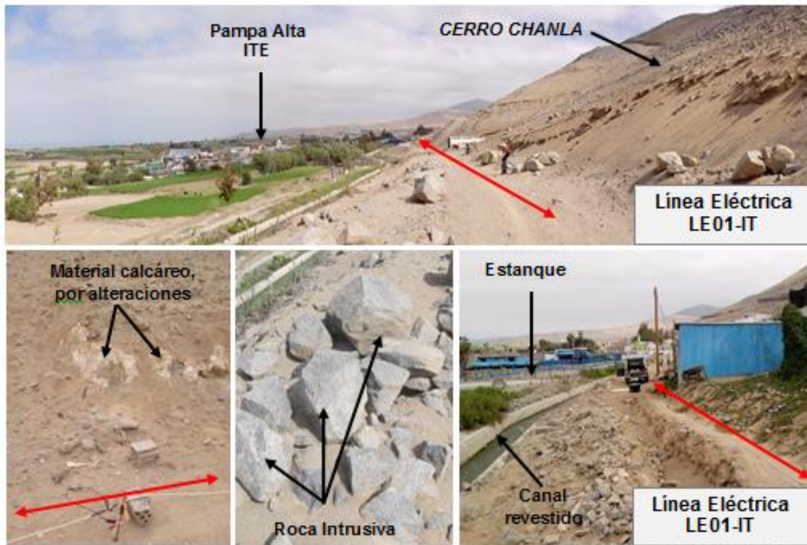
Figura 21: Vista de la línea eléctrica LE01-ITL.
