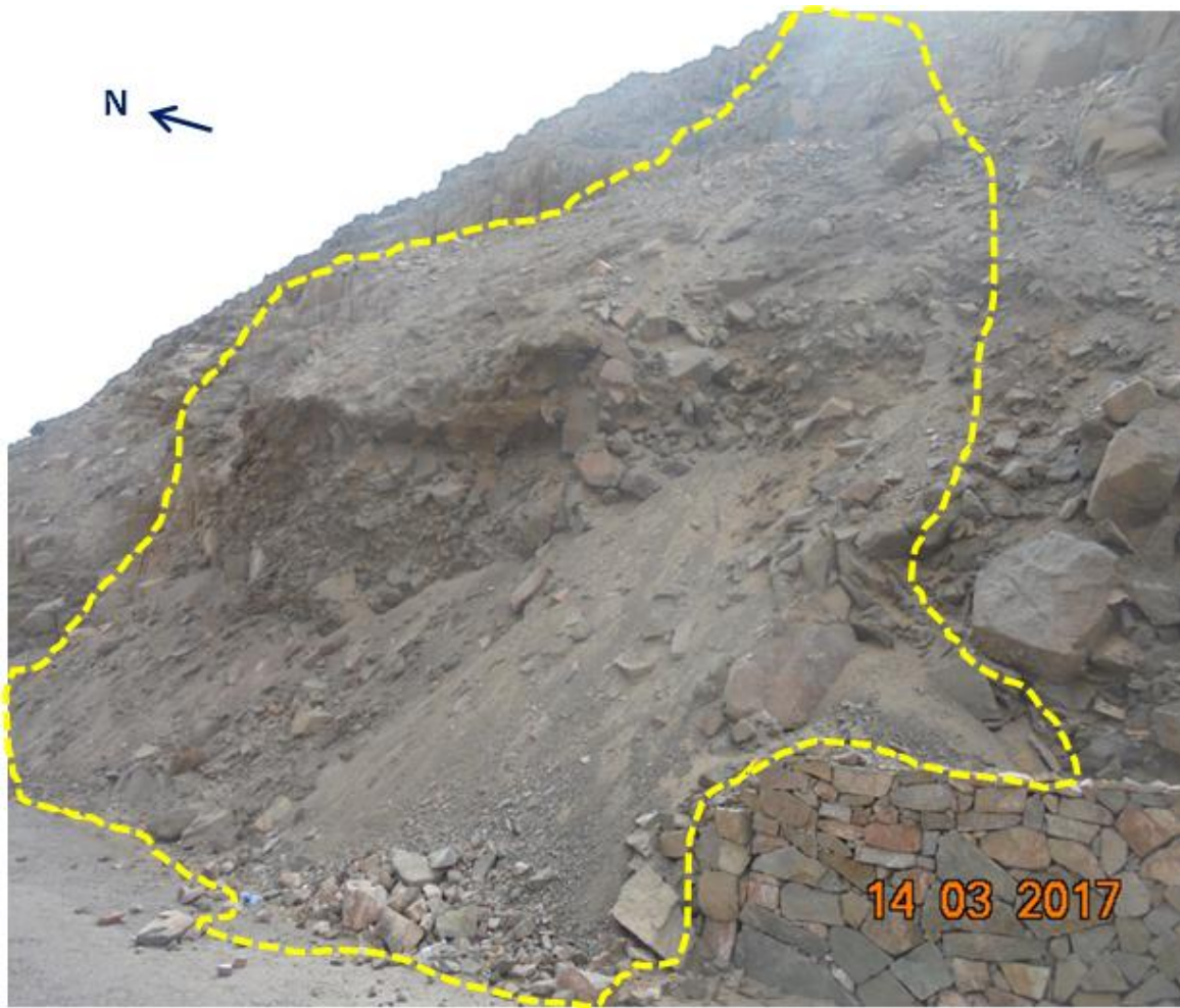
Figura 28: Deslizamientos en la carretera Ite-Moquegua km 790 a 1.5 km al noreste de Ite.
