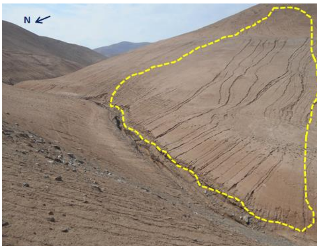
Figura 30: Zona susceptible a deslizamiento.
