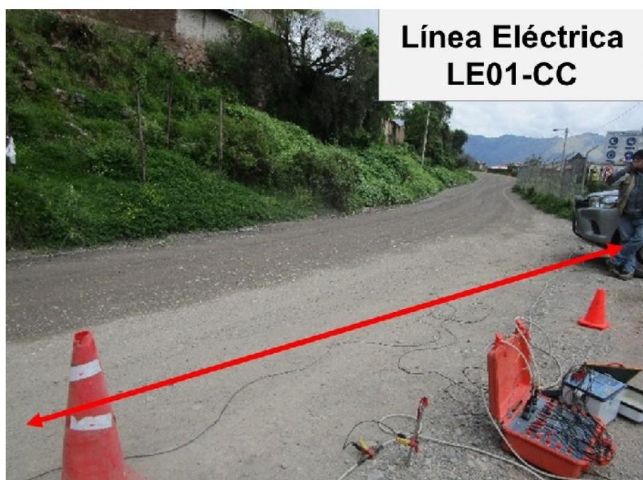
Figura 100. Vista de la línea eléctrica de Ccoypa (LE01-CC).
