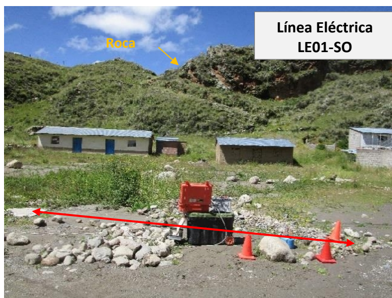
Figura 37. Vista de la línea eléctrica de Sol de Oro (LE01-SO).
