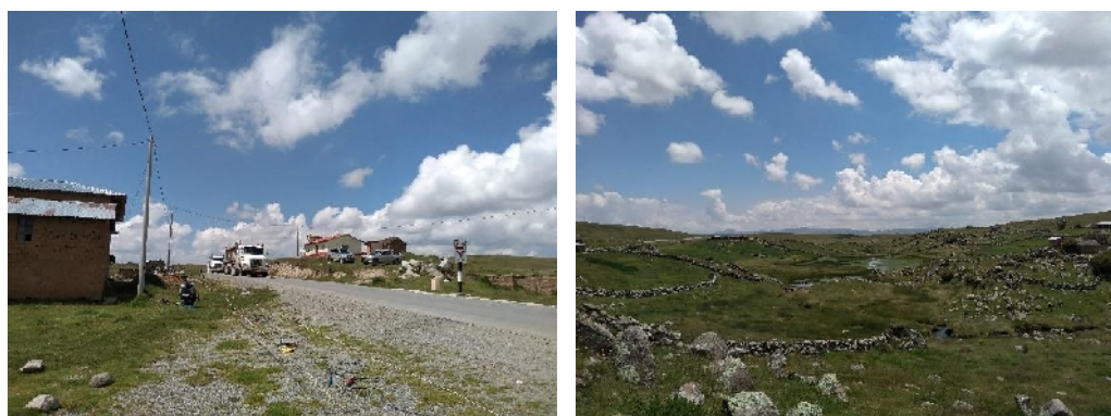
Figura 2c.- Viviendas de adobe y morfología de la localidad de Hualpamayo
