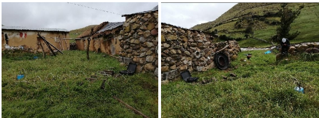
Figura 2b.- Viviendas típicas en la localidad de Halanta
