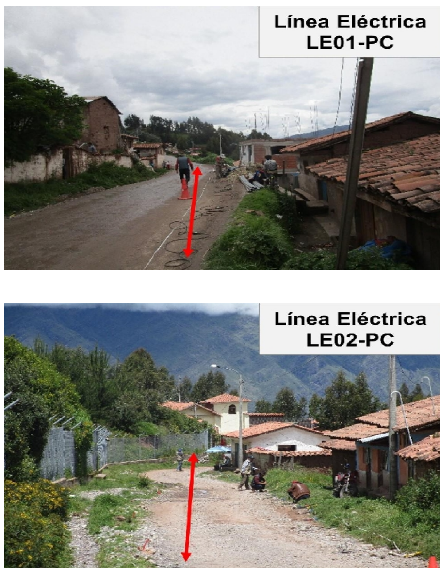
Figura 107. Vista de las líneas eléctricas en Paccarectambo (LE01-PC y LE02-PC).
