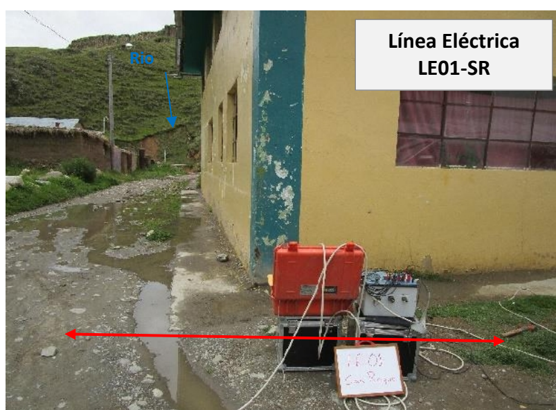
Figura 31. Vista de la línea eléctrica de San Roque (LE01-SR).
