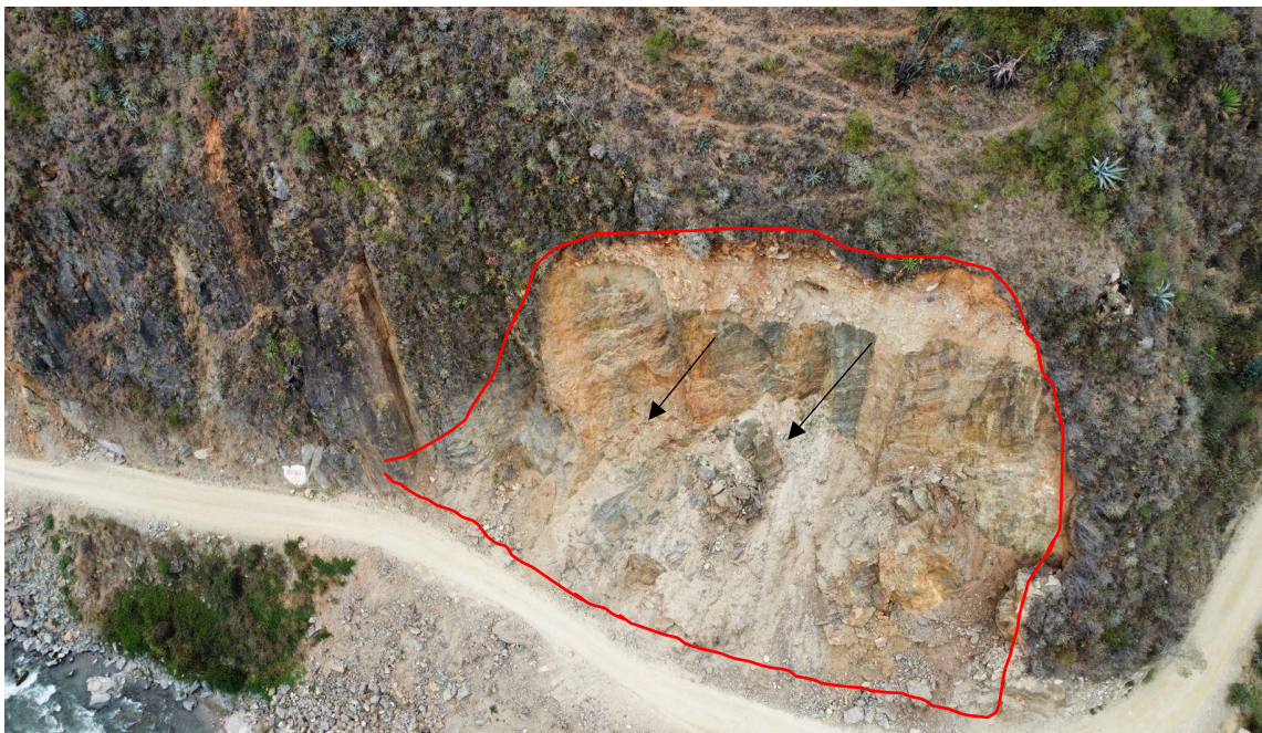
Figura 7.- Zona de derrumbe, cuando se activa en época de precipitaciones excepcionales los materiales se desplazan a favor de la pendiente obstaculizando la vía de acceso a poblados ubicados en el distrito de Ambo, incluso estos podrían caer al río Huallaga ocasionando el represamiento del mismo y originar una posible inundación.
