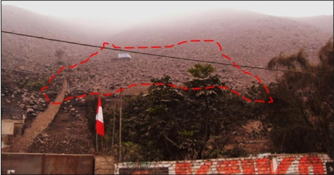
*Figura 2.7: La línea segmentada de color rojo muestran caídas de rocas en el extremo norte del frontis de la planta de Sedapal.*
