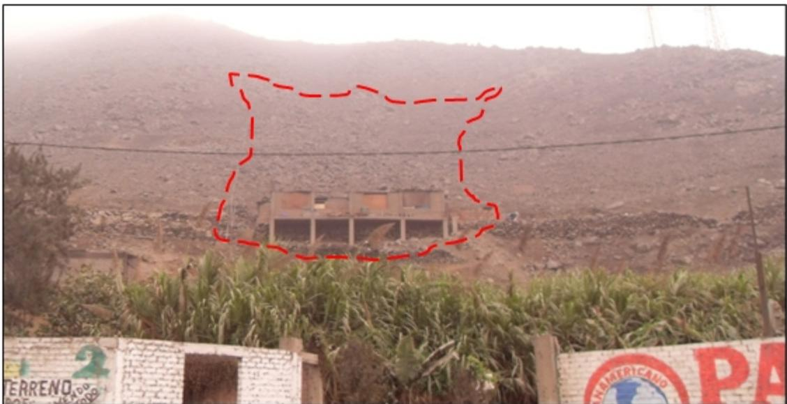
*Figura 2.8: La línea segmentada de color rojo muestran caídas de rocas en el extremo noreste del frontis de la planta de Sedapal.*
