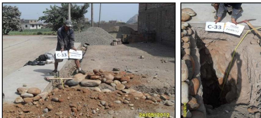
Figura C-33: Se observa la calicata tanto en superficie como en profundidad.
