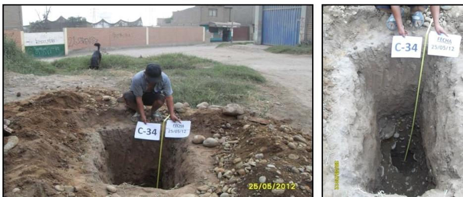
Figura C-34: Se observa la calicata tanto en superficie como en profundidad.
