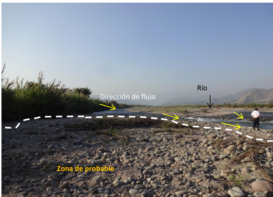
Figura 29: Río Mala, el interlineado (blanco) delimita la zona que sería invadida por el flujo hídrico ante el incremento del caudal del mismo.
