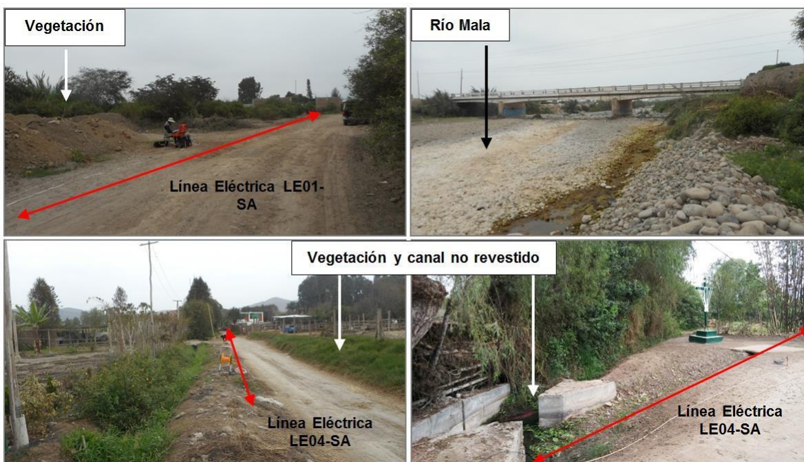
Figura 21: Vista de las líneas eléctricas LE01-SA y LE04-SA
