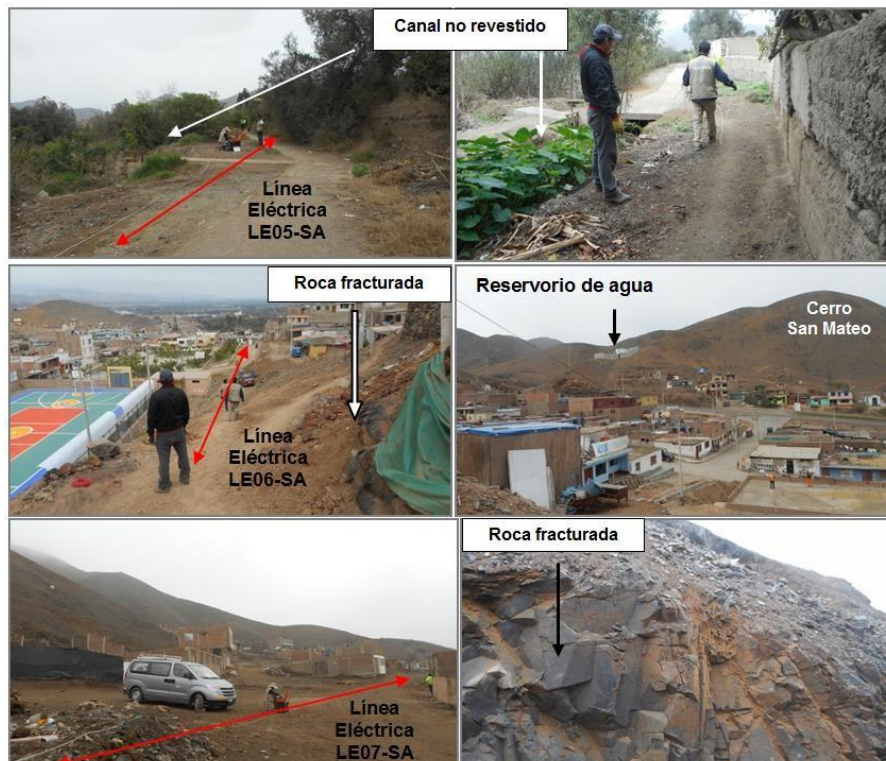
Figura 19: Vista de las líneas eléctricas LE05-SA, LE06-SA y LE07-SA.
