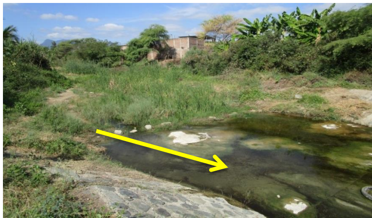
Figura 23: En las intersecciones de jirón Loreto con Pasco, empieza la canalización de un Canal, el mismo que se encuentra sin mantenimiento y con agua empozada, siendo foco de infecciones y enfermedades. La flecha amarilla indica la dirección del flujo.
