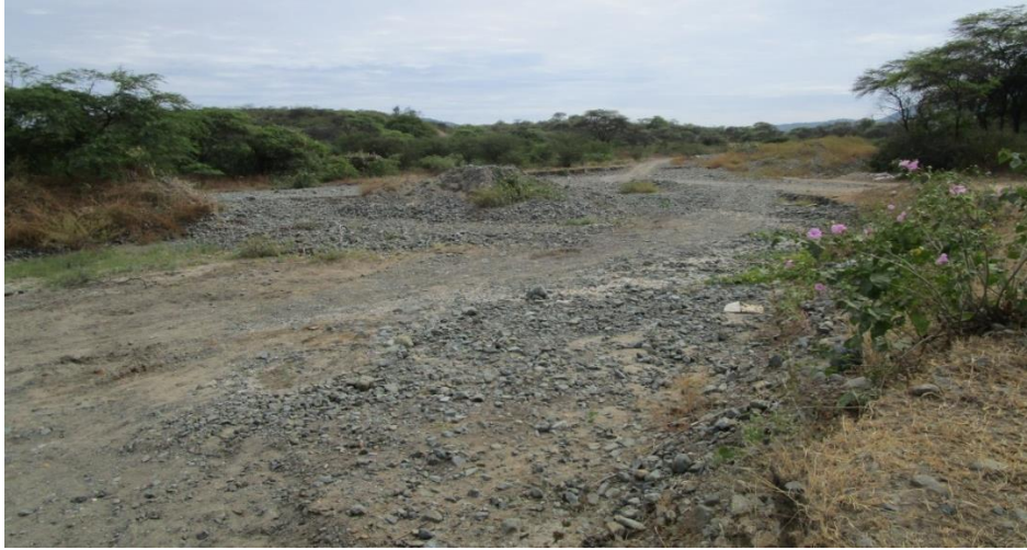
Figura 20: En la quebrada Salao se extrae material de cantera, alterando la topografía de la zona y dejando material en forma de “barreras” que impiden el fácil flujo del agua.
