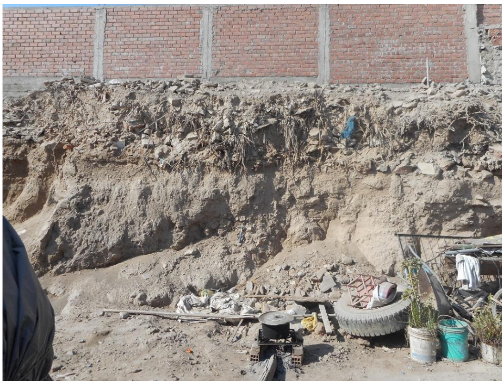
Figura 10: Depósitos os aluviales, conformados por arenas de grano fino a medio con intercalaciones de limos arcillosos, sobre los cuales se asienta la zona urbana del distrito de San Luis
