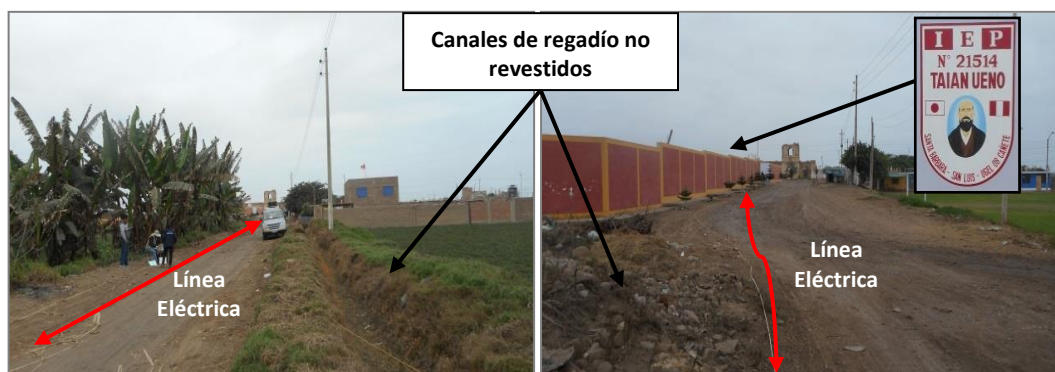
Figura 22: Vista de la línea LE02-SL
