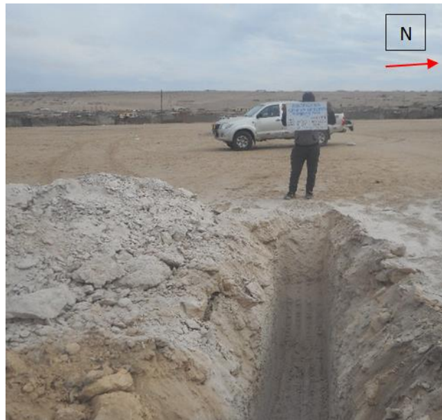
Figura 9: Excavación de la calicata CAA-01, ubicada en el cerro Intiorko, se encontró a 0.30m rocas volcánicas del tipo de tobas riolíticas de color blanco, pertenecientes al miembro superior de la Formación Huaylillas.
