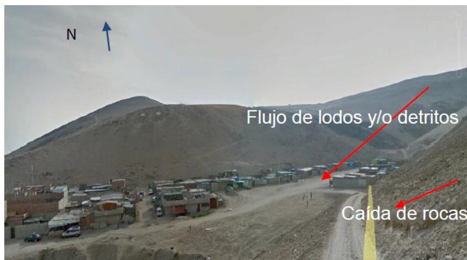
Figura 17: Flujos de lodos y/o detritos, así como caída de rocas, a inmediaciones de la quebrada del Diablo.
