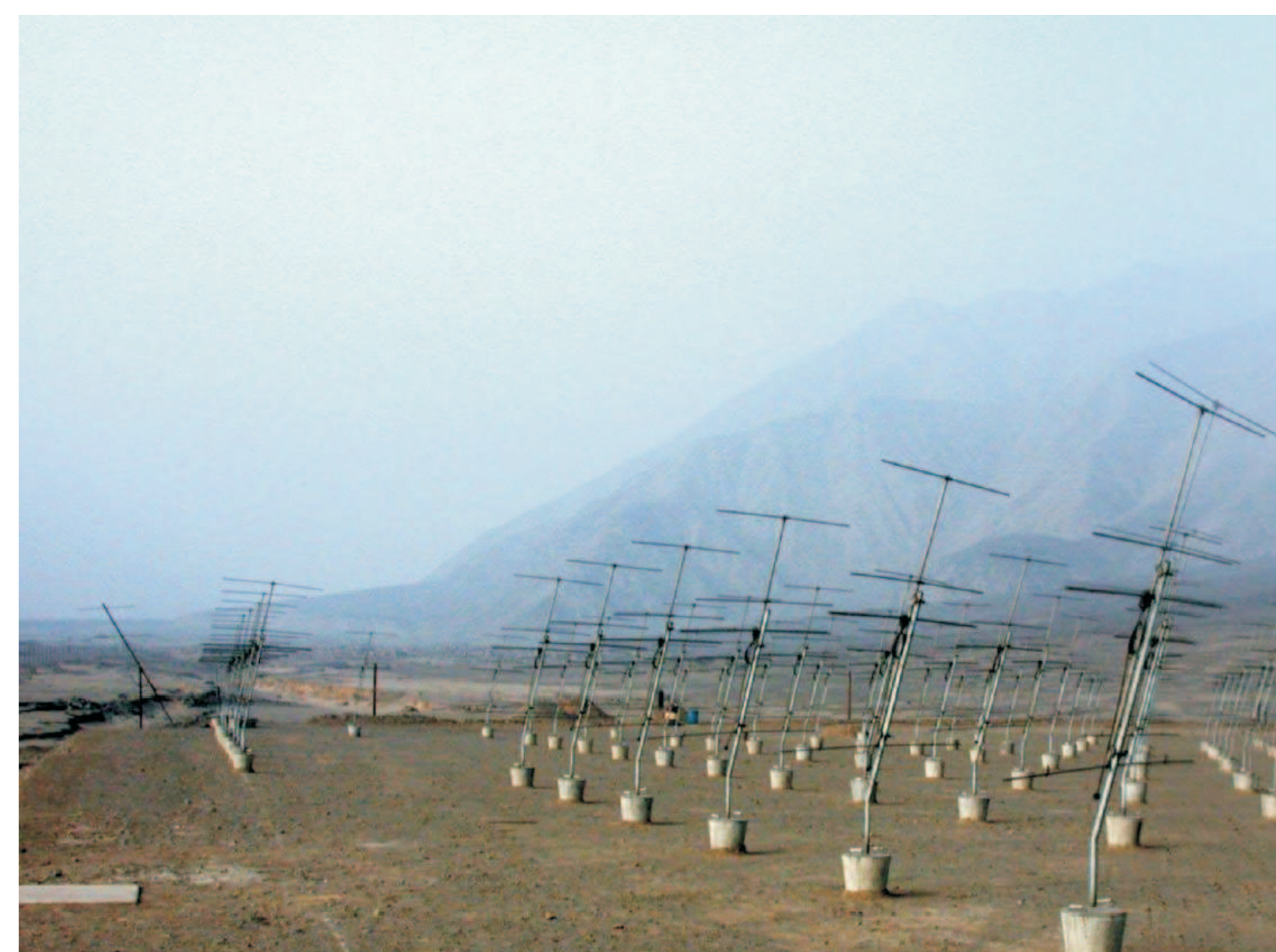
Figura 2: Detalle de la forma como están colocados los dipolos de la antena SOUSY, opción de apunte a 15° de la vertical, a ser usada próximamente para el estudio de la ionosfera.
