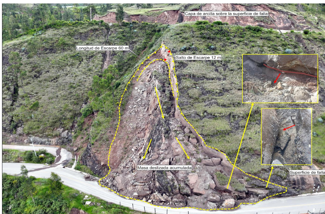
Figura 33.- Deslizamiento (29 de marzo, 2025) en el sector Limacpata-puente Ollayachoc.
