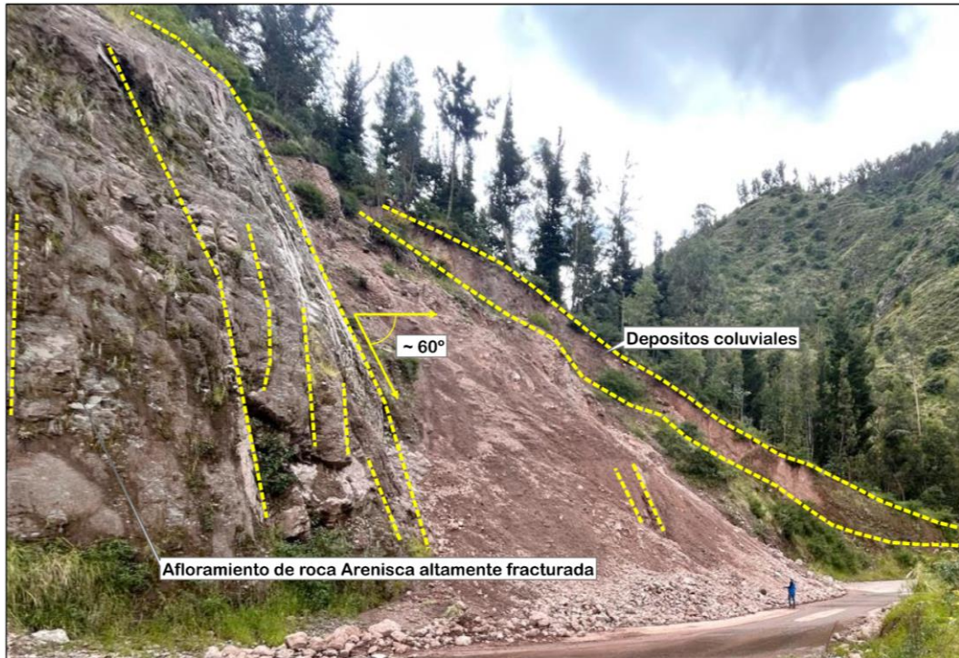
Figura 23.- Depósitos coluviales y roca tipo areniscas en el sector Upina.
