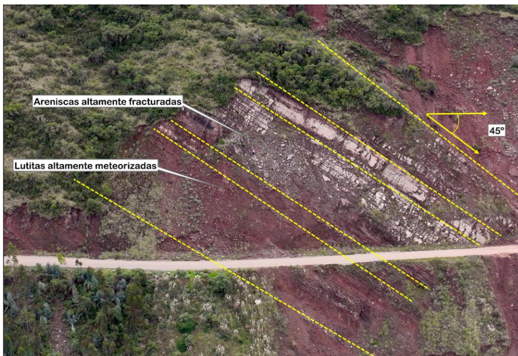
Figura 22.- Areniscas altamente fracturadas que condicionan la generación de deslizamientos y flujos.
