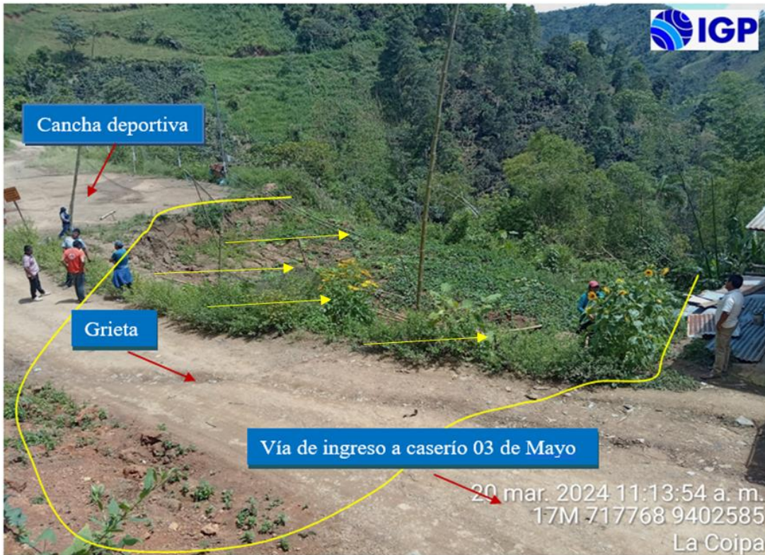
Figura 25.- Deslizamiento (línea amarilla) identificado en la vía de ingreso hacia el caserío 03 de mayo
