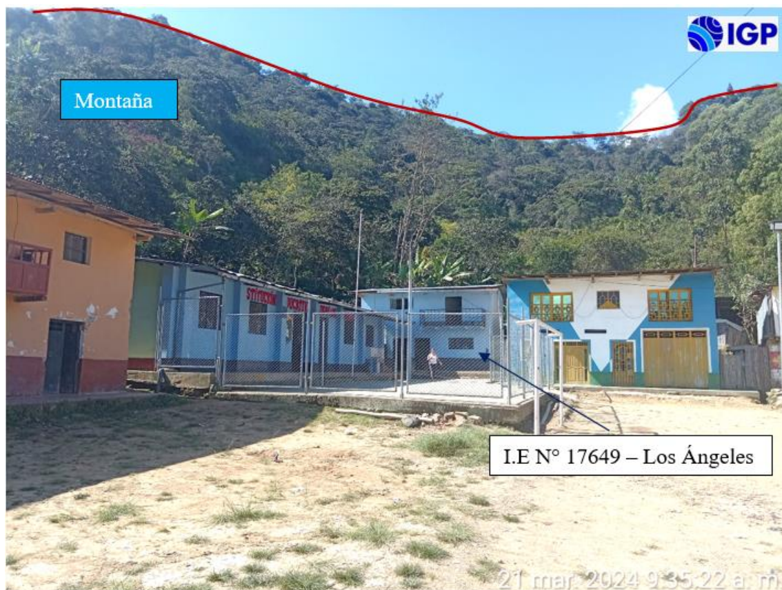
Figura 13.- Elevaciones del tipo montaña (debajo de línea marrón) situadas en la parte posterior de la I.E N°17649 – Los Ángeles, específicamente en el extremo sur del caserío Los Ángeles, se encuentra cubierta de vegetación
