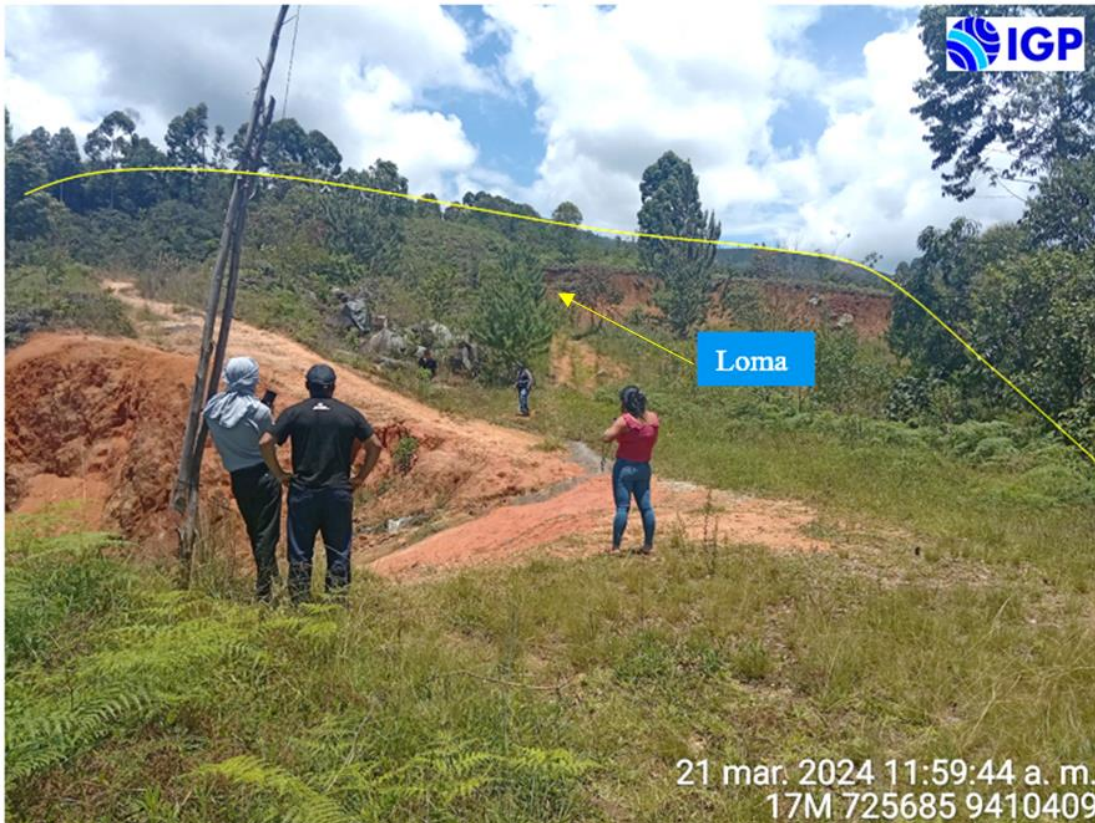
Figura 18.- Unidad geomorfológica loma o lomada visualizada desde la parte baja de planta de tratamiento de agua
