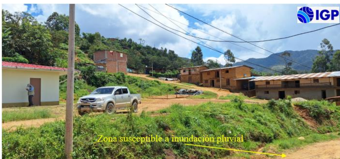
Figura 38.- Zona susceptible a inundación pluvial situada en la parte baja de I.E.I N° 166 y a ambientes de establecimiento de salud
