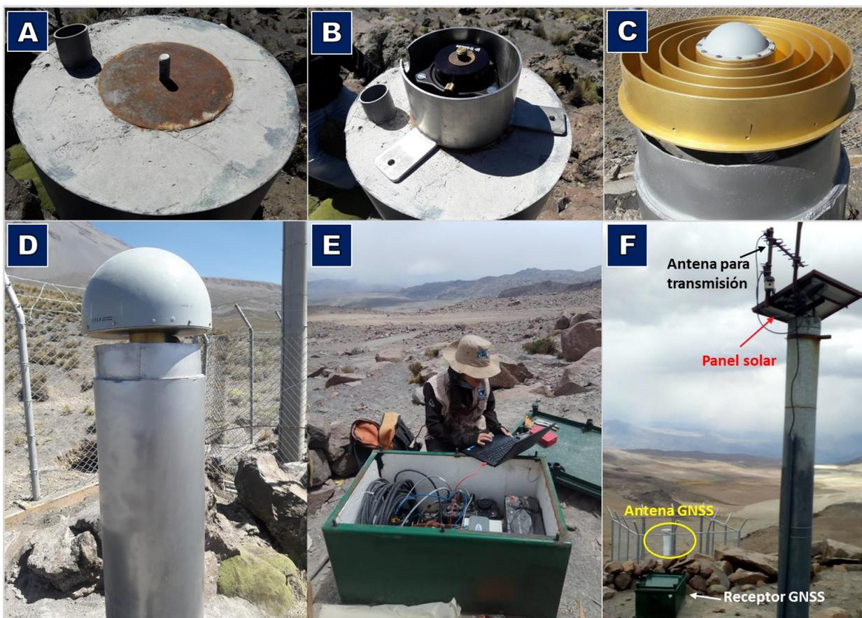
**Figura 4.-** Instalación de estación GNSS: A) monumento, B) base nivelante y ducto protector, C) antena, D) domo protector, E) configuración del receptor y F) estación completa GNSS.
