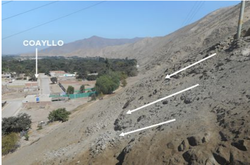
Figura 39: El casco urbano del área urbana de San Pedro de Coayllo es susceptible a caída de rocas, ante la ocurrencia de un sismo.
