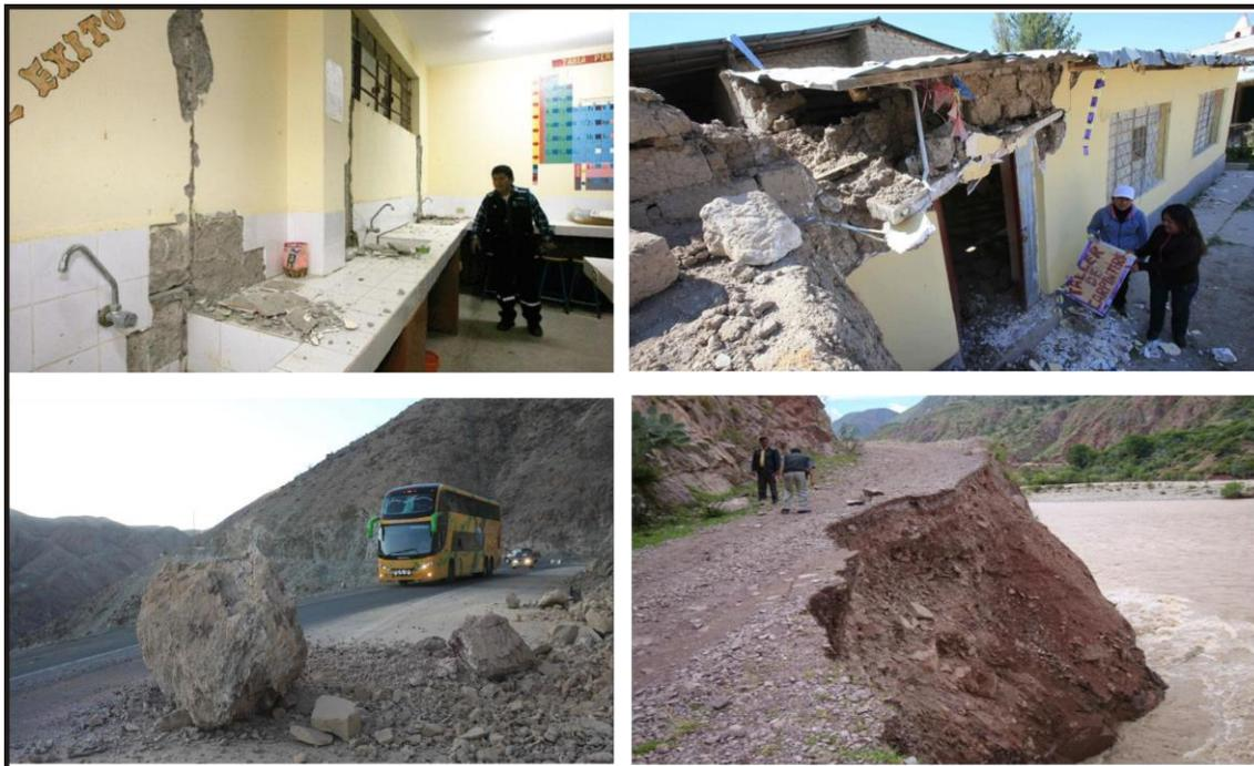
**Figura 4.-** Imágenes de viviendas dañadas por el sismo de Coracora y Puquio, fisuras y caída de paredes de adobe. Asimismo, caída de piedras y deslizamientos en zonas inestables en carreteras.
