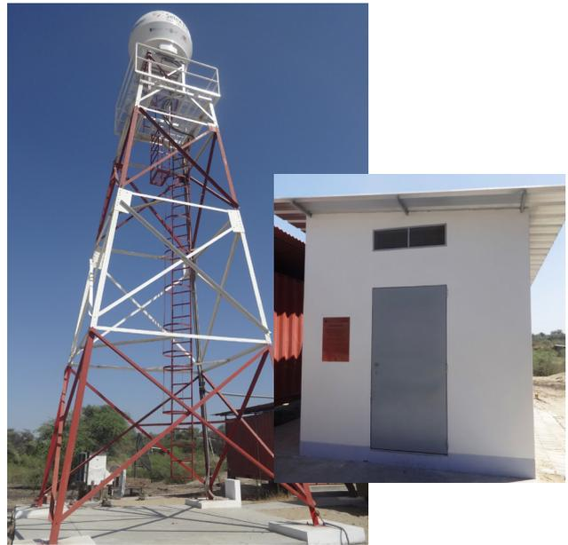
Figura 2. A la izquierda se muestra la torre metálica de 10 metros de altura, con la antena parabólica en su parte superior, y a la derecha la cabina de seguimiento con los equipos electrónicos del radar de lluvias.
