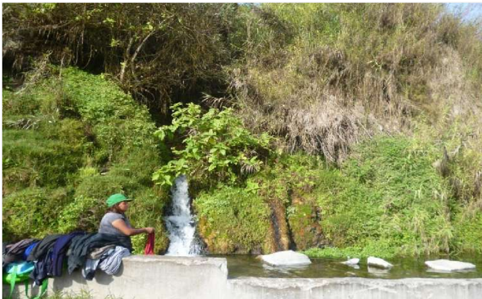
Figura 53: Presencia de agua subterránea en la parte baja de los acantilados ubicados en el extremo oeste de la ciudad de Barranca.
