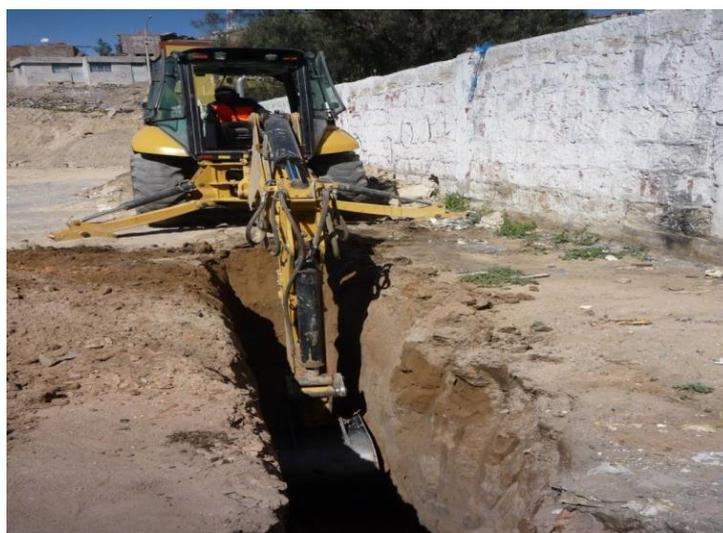
Figura 4.12: Calicata construida por una retroexcavadora proporcionada por el Municipio del Distrito de Sachaca.
