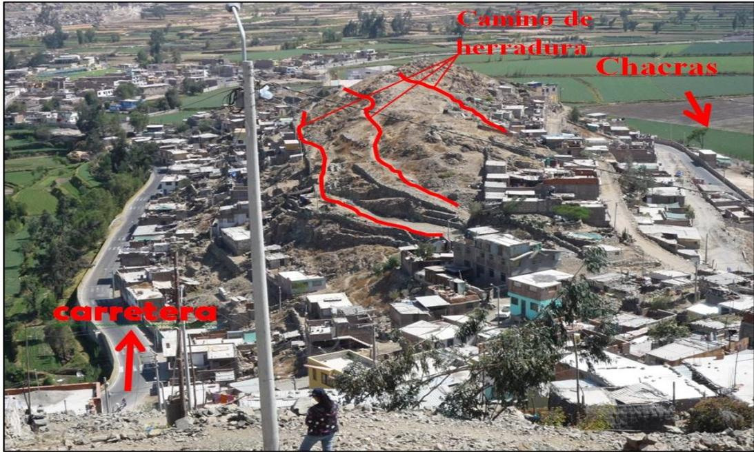
Figura 4.4: Viviendas asentadas sobre las laderas del cerro "Arguedas". Se observa la presencia de herraduras sobre la cima. El rango de pendiente en la zona es de 25° a 40°.
