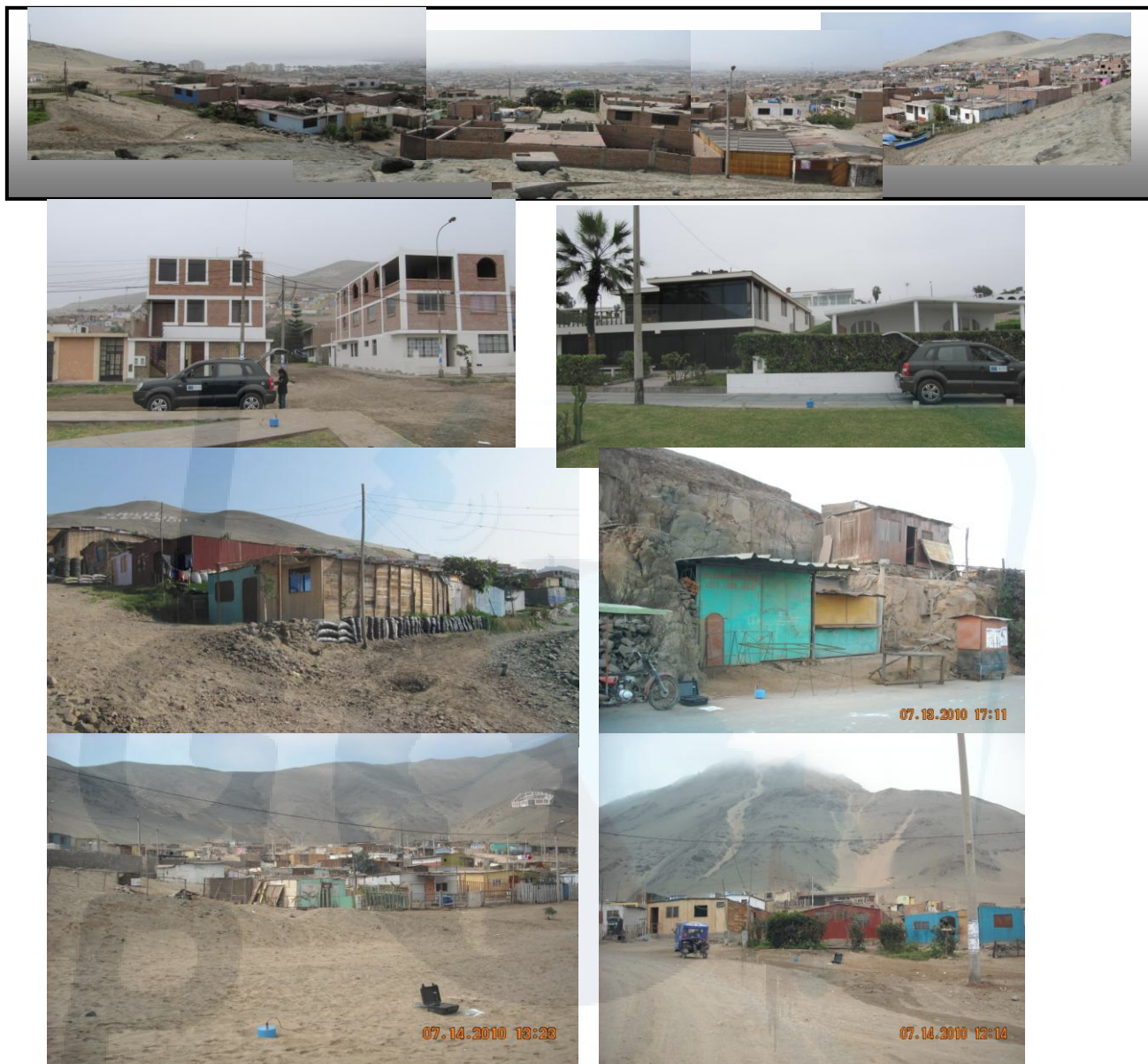
Figura 7.- Vistas del tipo de suelos y viviendas del Distrito de Santa Rosa. En el extremo superior se observa una vista panorámica del Distrito con viviendas de material noble y otras precarias. Estas últimas se ubican en las laderas de los cerros sostenidos por costales de arena y otras empotradas en roca, y/o en las faldas de lomeríos presentes en el Distrito.
