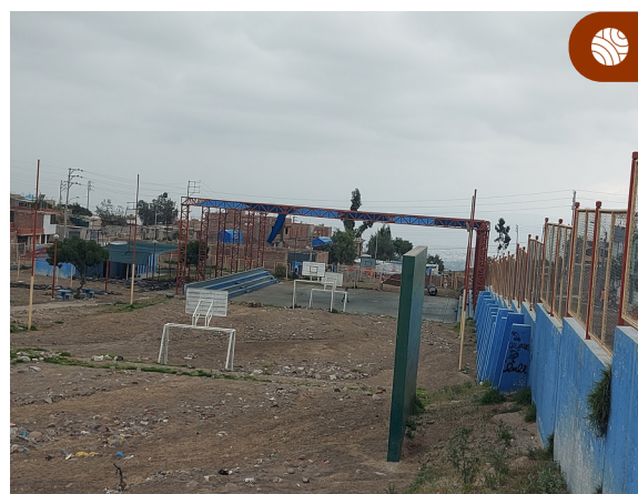
Figura 25. Vista de una losa deportiva del A. H. Sol de los Andes expuesta al descenso y desborde de lahares por la quebrada Innominada.
