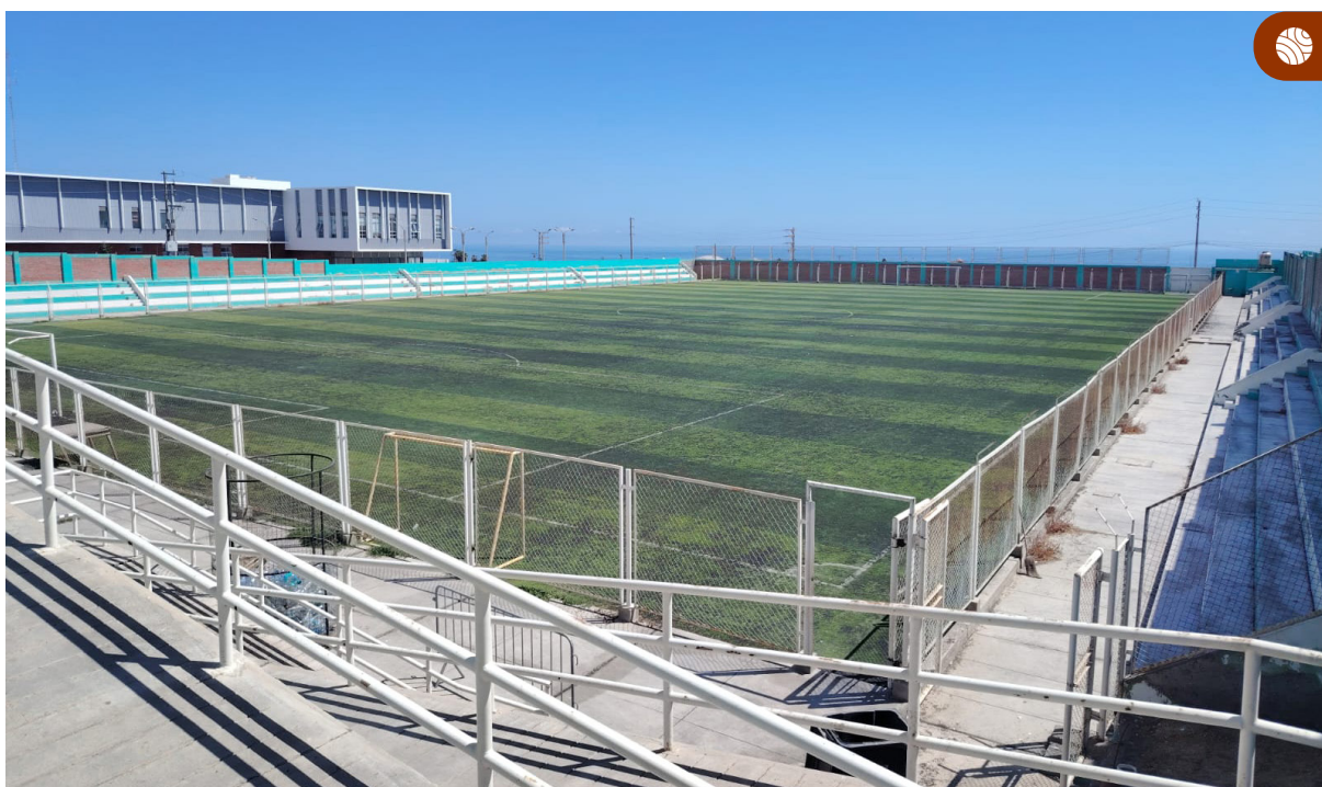
Figura 35. Vista del estadio César Vallejo, Mollendo, seleccionado como zona de albergue temporal.
