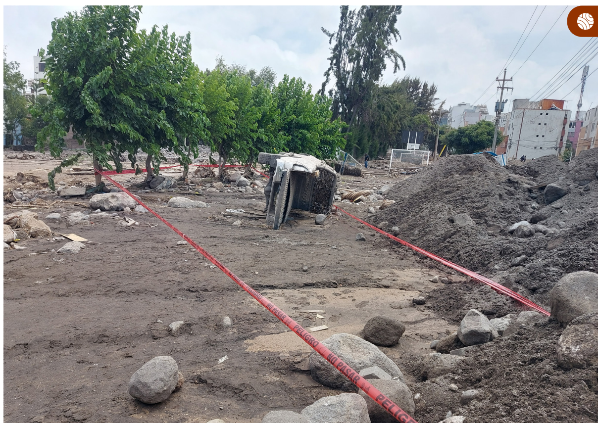
Figura 13. Vista de la quebrada Chullo (distrito de Cayma) donde se observa la acumulación de sedimentos y bloques de rocas transportados por lahares ocurridos en febrero de 2026. Dichos lahares ocasionaron daños a vehículos e infraestructura urbana.
