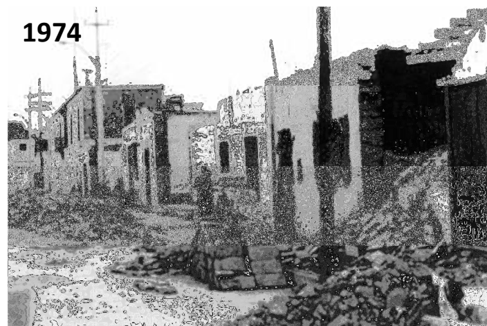
Figura 3.17. Daños ocasionados por los sismos de 1966 (Casona de San Marcos) y 1974 (distrito de Chorrillos).
