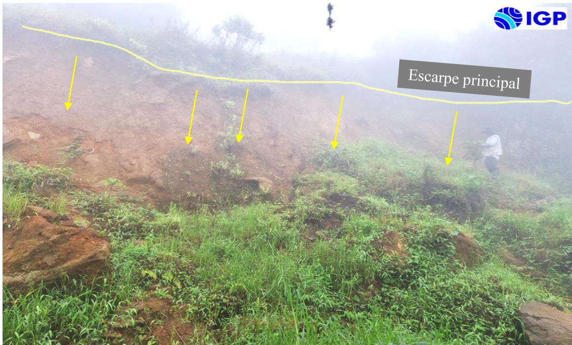
Figura 16.- Escarpe principal de deslizamiento reconocido en extremo noroccidental de sector Tiña Rumbe que presenta un salto o desnivel topográfico de aproximadamente 5 a 6 m
