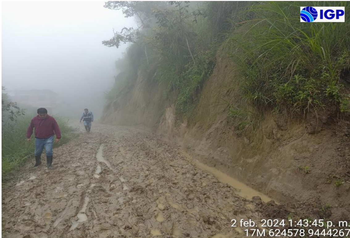
Figura 15.- Taludes susceptibles a la ocurrencia de derrumbes durante periodos de lluvias intensas, ubicados a 260 m al norte de la plaza principal de Santo Domingo
