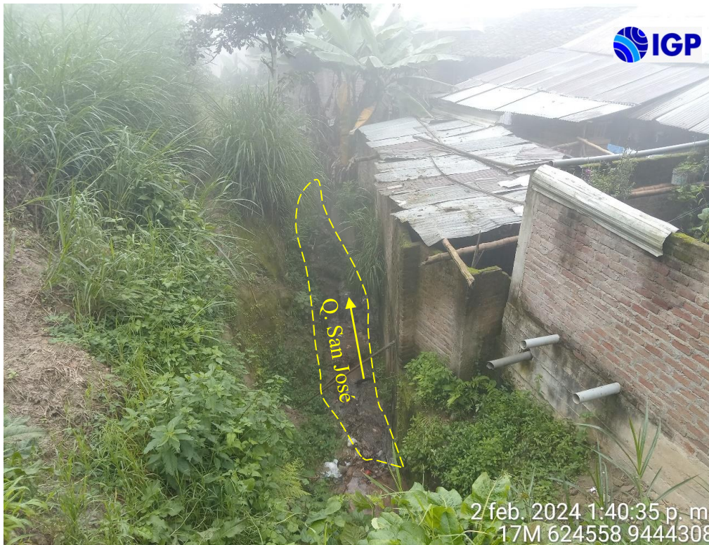
Figura 11.- Depósito aluvial reciente conformado por material fino (arenas y limos) dispuestos sobre cauce de la quebrada San José (polígono amarillo) en las inmediaciones de las viviendas de la localidad de Santo Domingo
