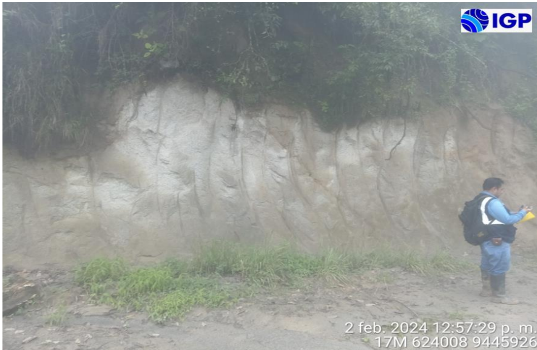
Figura 9.- Afloramiento de roca intrusiva del tipo tonalita meteorizada y susceptible a movimientos en masa reconocida en el sector San José (2 km al noroeste de la plaza principal de Santo Domingo)
