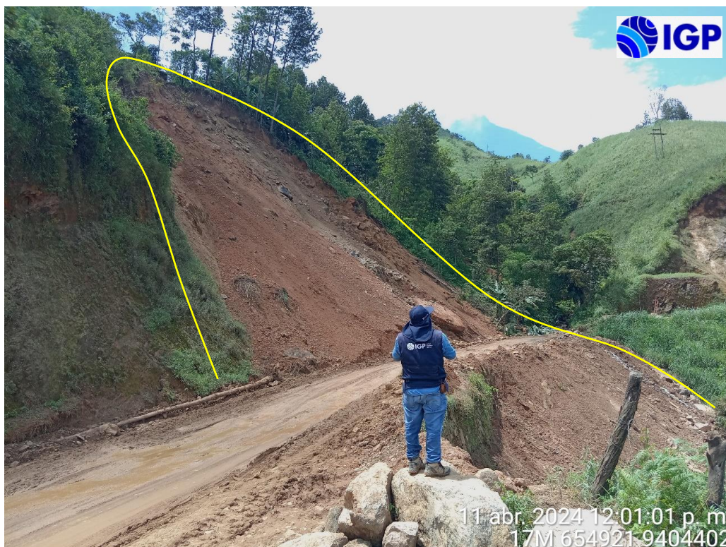
Figura 8.- Unidad geomorfológica vertiente con depósito de deslizamiento (línea amarilla) situada en la vía Canchaque - Huancabamba
