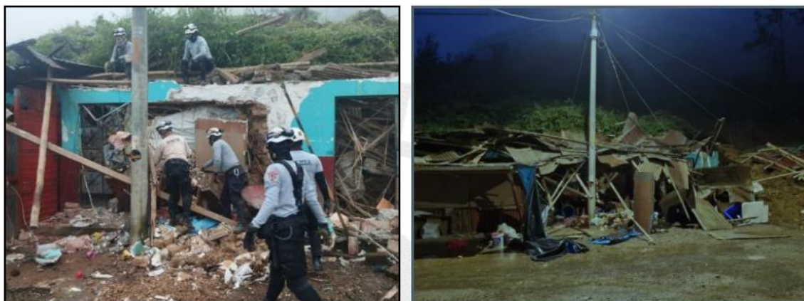
Figura 3.- Viviendas destruidas en el sector Villa Palambra por el deslizamiento ocurrido el 04 de marzo de 2024 (Fuente: Indeci, 2024)
