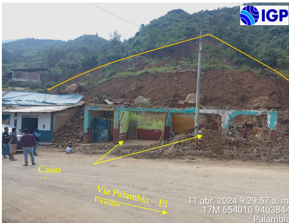
Figura 4.- Unidad geomorfológica vertiente con depósito de deslizamiento (línea naranja) situada en la vía Palambra – Faique
