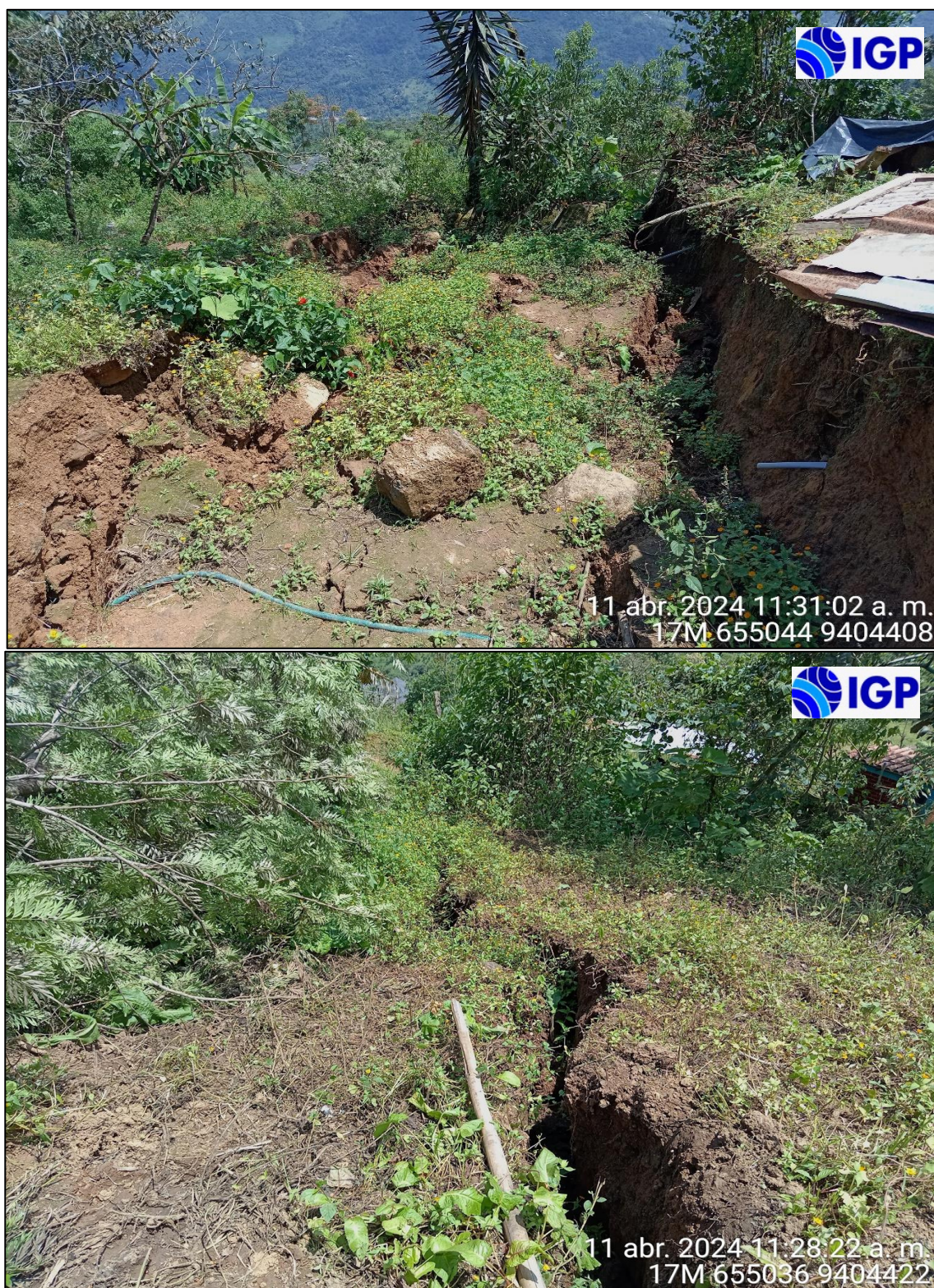
Figura 18.- La imagen superior muestra asentamiento diferencial del suelo y la imagen inferior una grieta en el suelo de 20 m de longitud (dirección noroeste – sureste)
