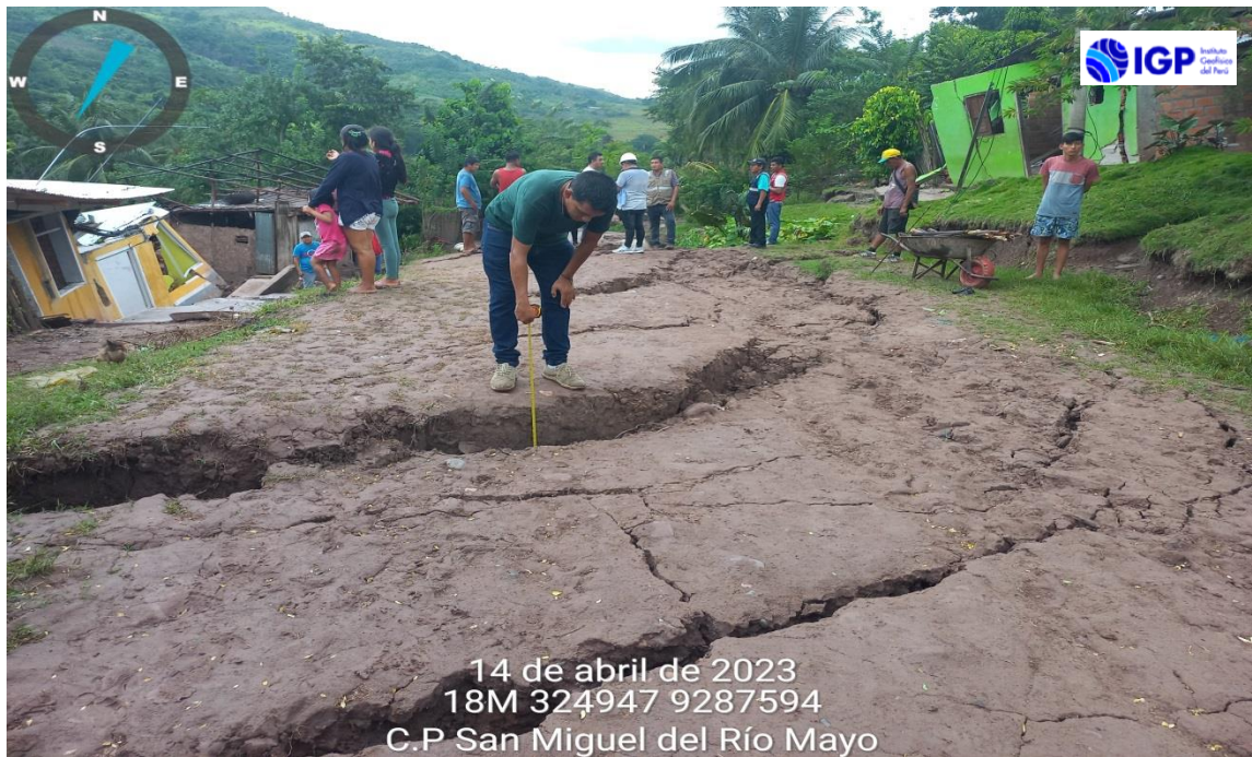
Figura 21.- Grietas de tracción en diferentes direcciones, a consecuencia del deslizamiento
