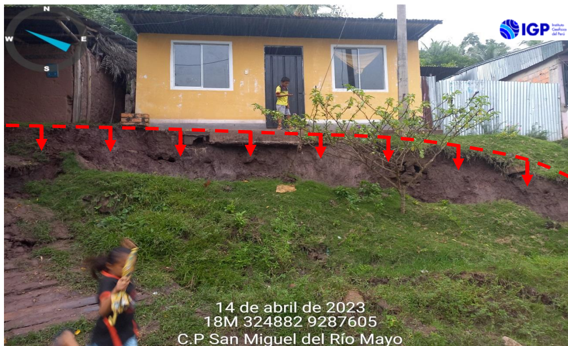
Figura 15.- Zona de arranque del deslizamiento rotacional regresivo, presenta un salto de 1.30 m en dirección noroeste - sureste
