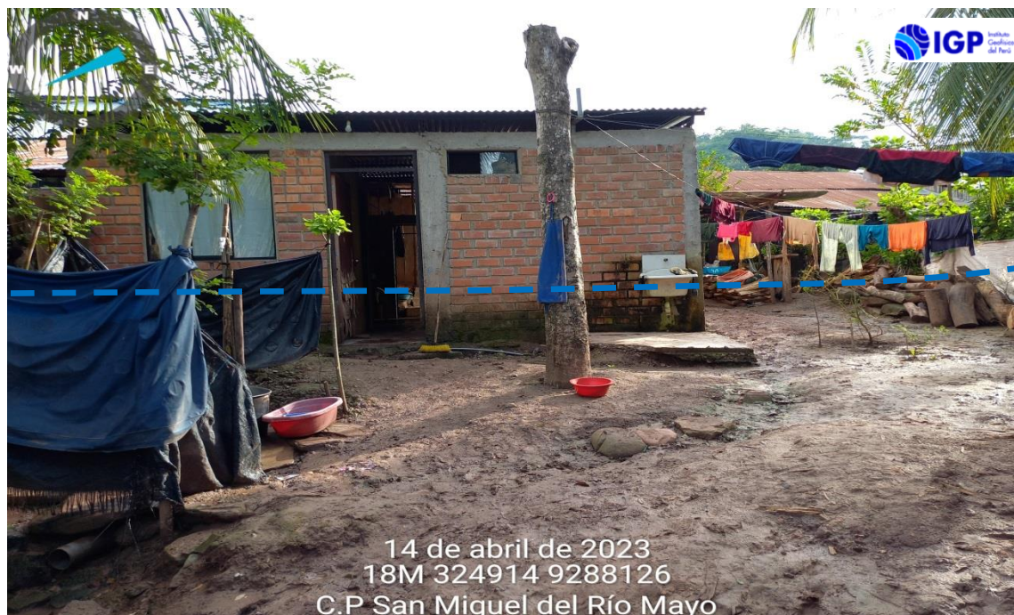
Figura 23.- Viviendas asentadas en la margen derecha del río Mayo, la línea celeste indica la altura que llega el agua
