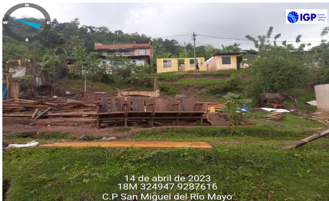
Figura 20.- Viviendas afectadas en la parte baja como consecuencia del deslizamiento de tipo rotacional
