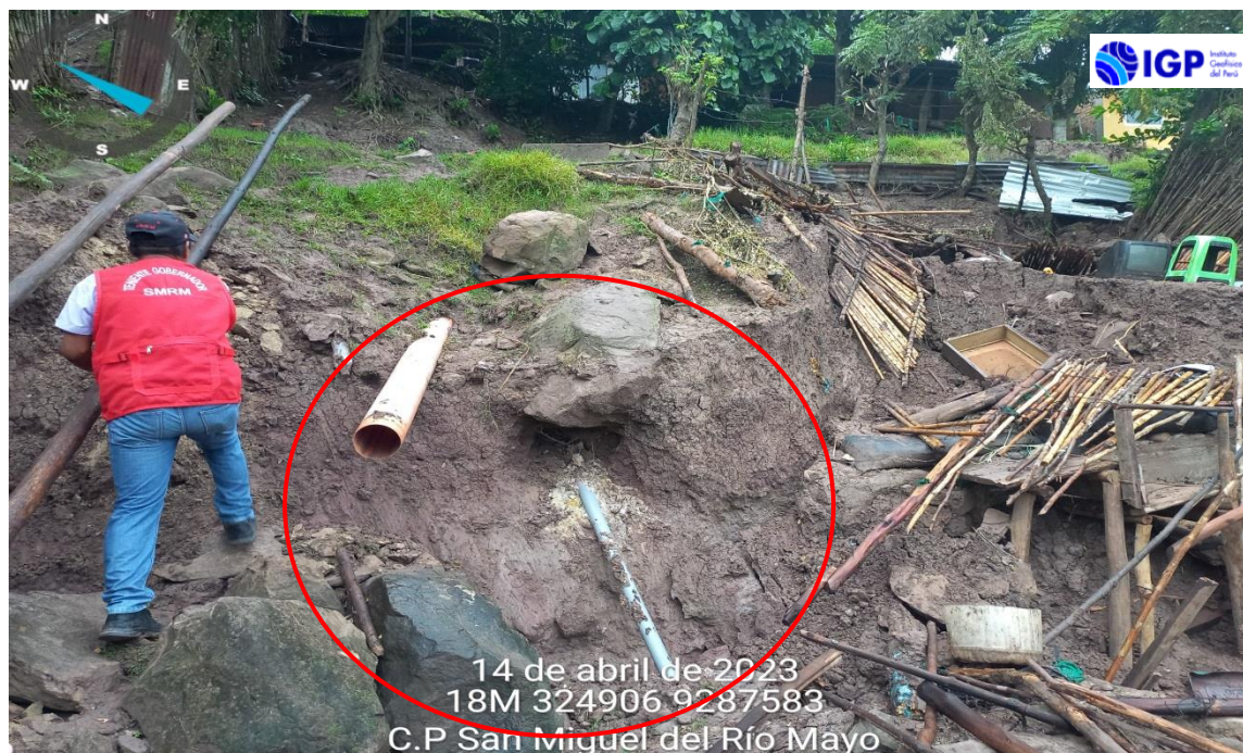
Figura 17.- El deslizamiento rotacional regresivo ha afectado el sistema de agua y desagüe del barrio Partido Alto
