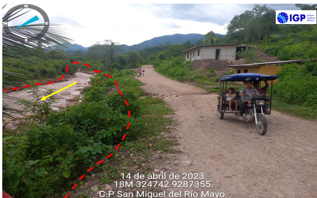
Figura 10.- Depósitos coluviales situados en la quebrada Mishquiyacu, conformado por clastos de diferentes diámetros. El área urbana se asienta en la margen izquierda de la quebrada. La flecha amarilla indica la dirección del flujo
