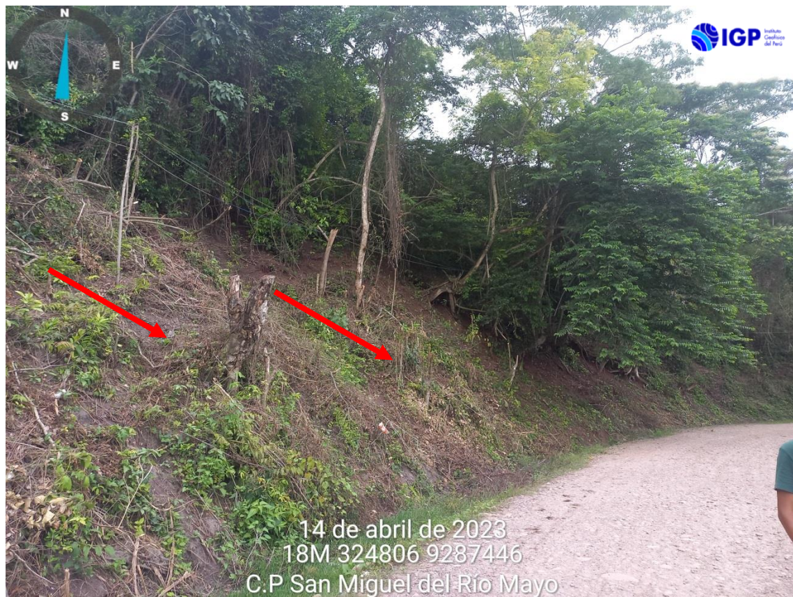
Figura 28.- Caída de suelos identificado a 580 m al suroeste de la plaza municipal del centro poblado San Miguel del Río Mayo, el mismo que podría afectar la trocha carrozable hacia Panjuy
