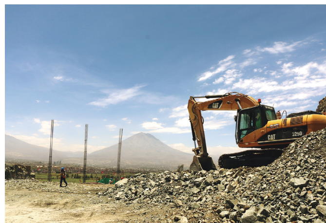
Proyecto de mejoramiento: trabajos de construcción de la nueva sede del IGP
