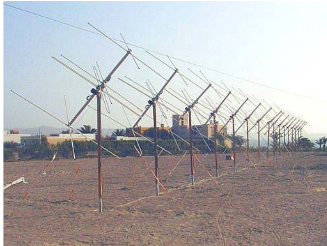
Figura 3-7 Arreglo de antenas tipo Yagi en Paracas
