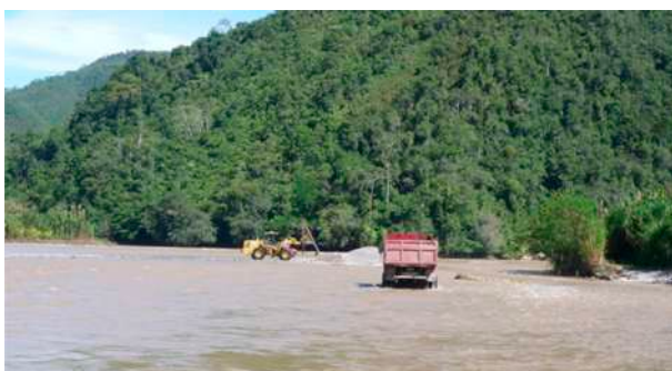
Labores de protección de riberas en las inmediaciones de Tingo María producto del desborde del río Huallaga.
