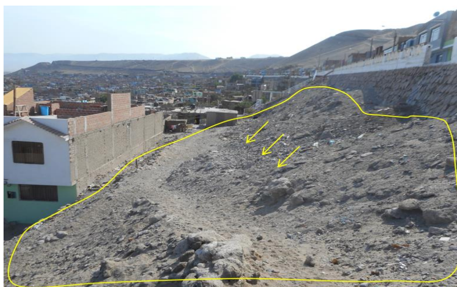
Figura 26: Zona susceptible a desprendimiento de suelo y clastos de gravas (línea amarilla) ante la ocurrencia de sismos.
