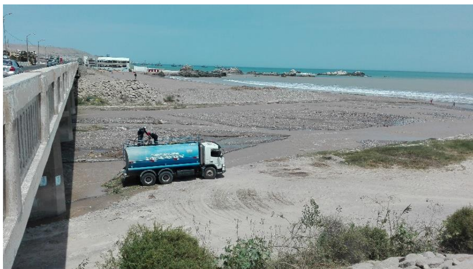
Figura 19: El lecho del río Osmore está cubierto por gravas redondeadas con arenas de grano medio a grueso.
