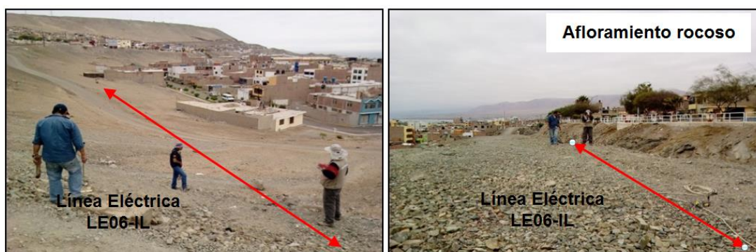
Figura 30: Vista de las líneas eléctricas LE06-IL.
