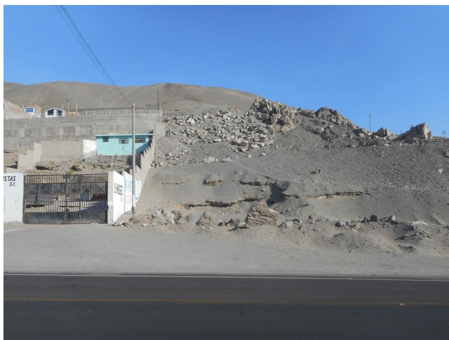
Figura 23: Laderas en las que aflora roca intrusiva de la Súper Unidad Punta Coles que se encuentra fracturada y meteorizada, debido a ello, ocurren desprendimientos constantes de bloques de rocas hacia la parte baja.
