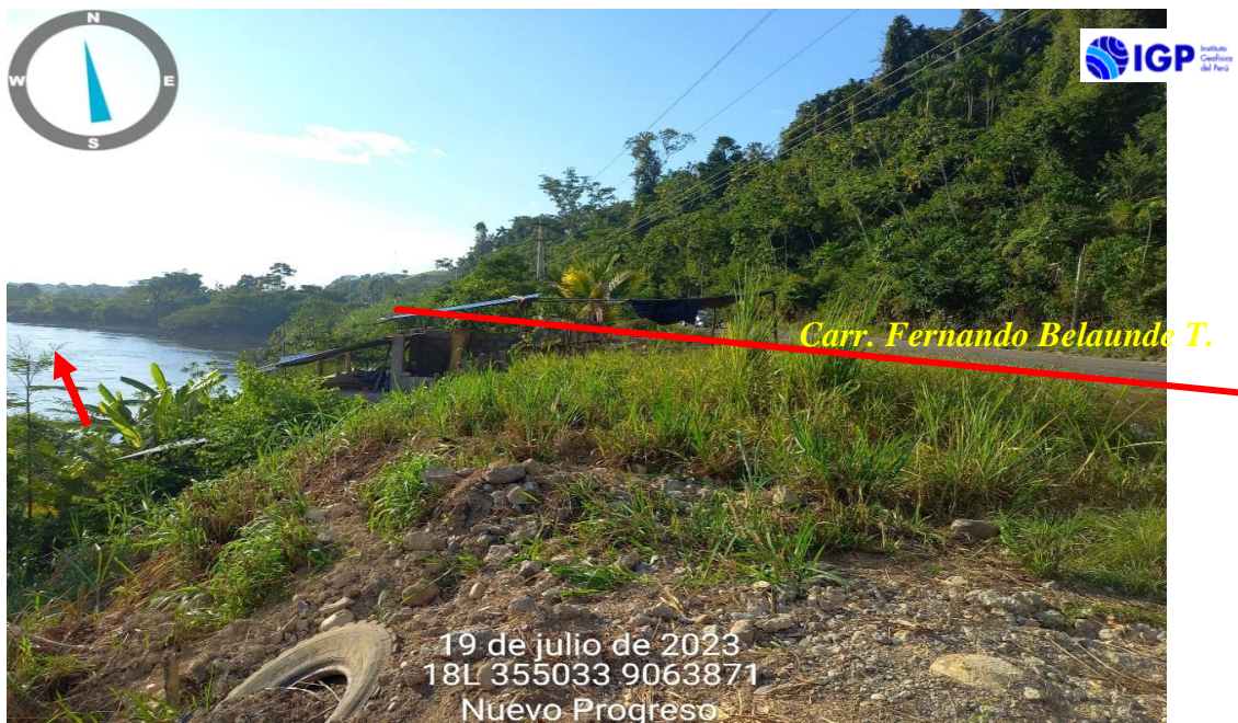
Figura 23.- La erosión fluvial podría afectar la vía principal Fernando Belaunde Terry. La flecha indica la dirección de flujo, por lo que es necesario se tomen medidas correctivas.
