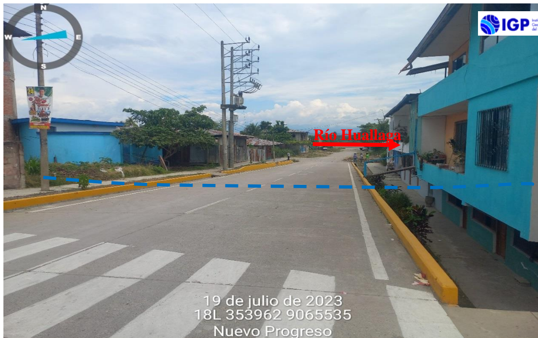
Figura 15.- Inundaciones fluviales generadas por el desborde del río Huallaga, margen derecha, afectando las viviendas que se asientan en la llanura aluvial. De acuerdo al testimonio de los pobladores, el límite de la altura de la inundación llega hasta la línea celeste
