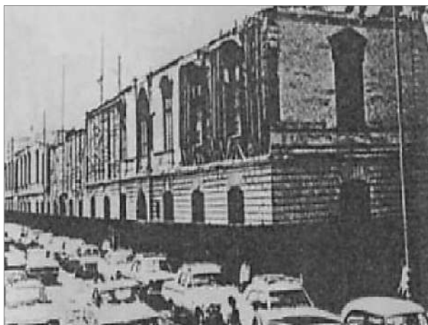
Figura 3.12. Daños ocasionados en la casona de San Marcos por el sismo del 17 de octubre 1966.
