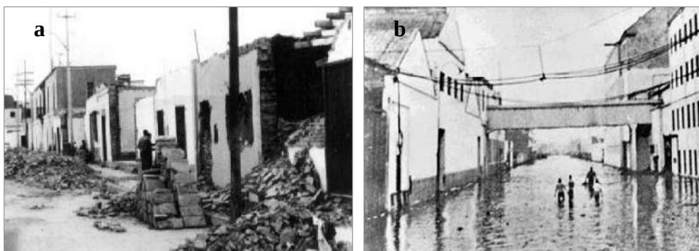
Figura 3.13. (a) Daños ocasionados en el Distrito de Chorrillos, (b) Jr. Loreto Cuadra 6 en el Callao después del tsunami producido por el sismo del 3 de octubre de 1974.
