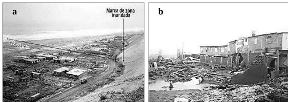
Figura 3.19. (a) balneario las Cuevas (km. 844 Sur). Nótese la marca de agua dejada por el tsunami en la ladera del cerro. (b) Balneario de “La Punta Vieja”, se observa la inundación dejada por el tsunami y el colapso de la cimentación de las viviendas
