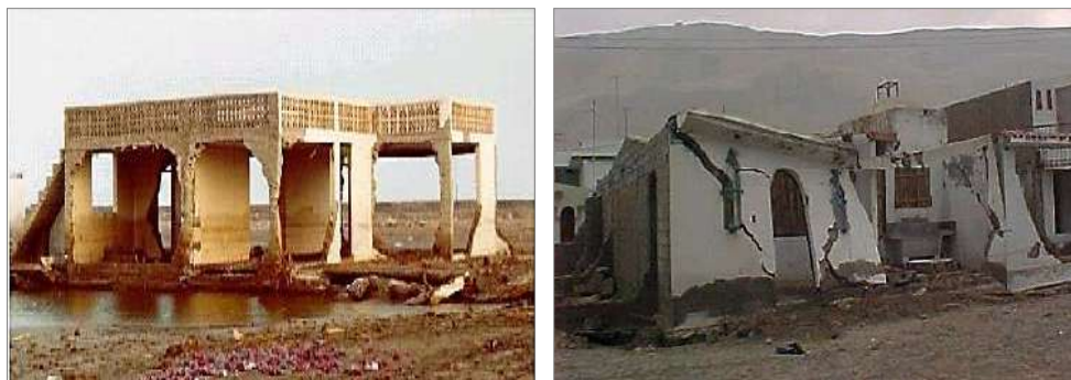
Figura 2.18. Daños producidos por el momento de flujo en viviendas con bloques de concreto en el balneario de La Punta, producto del tsunami del 23 de Junio del 2001, Arequipa.
