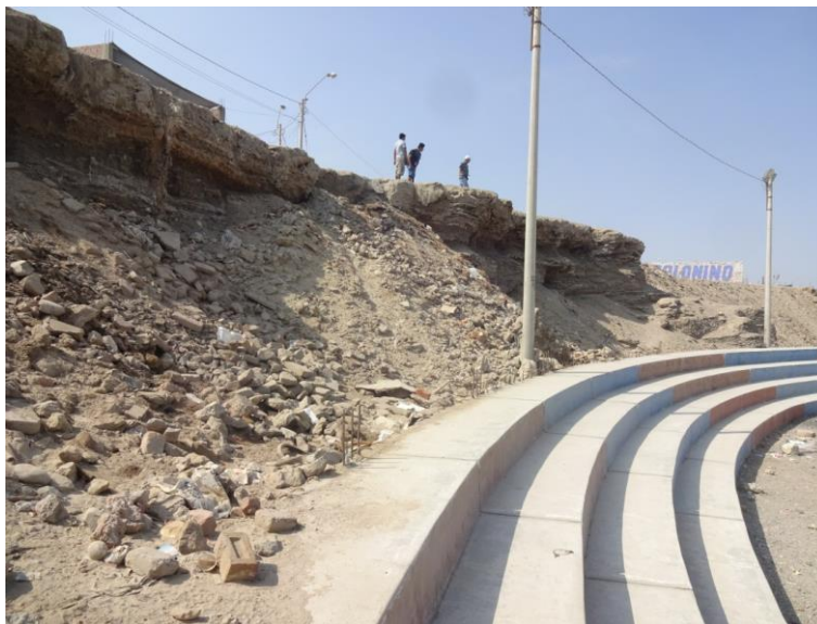
Figura 28: Materiales granulares que se desprenden hacia las gradas del coliseo.
