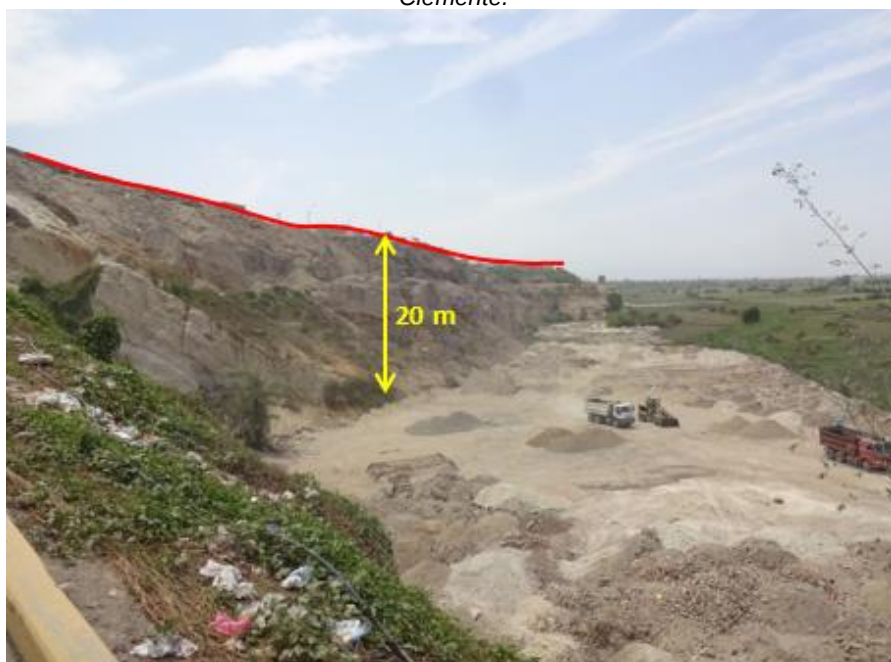
Figura 8: El acantilado presenta aproximadamente 20 m de desnivel y se encuentra conformado por materiales granulares (conglomerados y areniscas meteorizadas) que son aprovechados como canteras de agregados.
