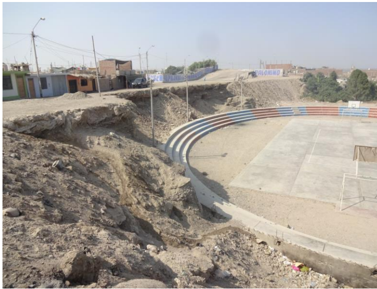
Figura 27: Coliseo deportivo del sector 4 y \frac{1}{2} ubicado a 470 m al norte de la plaza principal de San Clemente, se encuentra en una depresión de aproximadamente 10 m de profundidad. Se aprecia en la parte norte y oriental los conglomerados de la Formación Cañete con desprendimientos del suelo y clastos redondeados.
