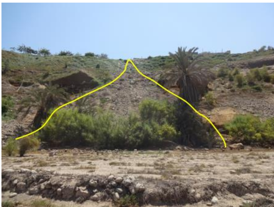
Figura 30: Desprendimiento de suelo y clastos a lo largo del acantilado que se ubica en el extremo sur del área urbana de San Clemente, debido a factores antrópicos (corte de talud para extraer agregados).
