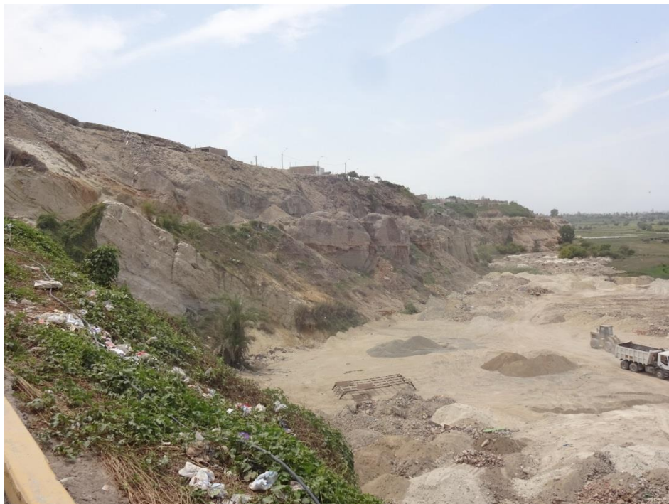
Figura 29: Desprendimiento de suelo y clastos a lo largo del acantilado que se ubica en el extremo sur del área urbana de San Clemente, debido a factores antrópicos (corte de talud para extraer agregados).
