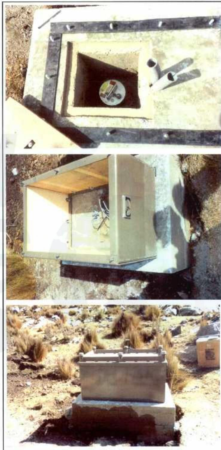
**Figura 5.** Fotos de la estación sísmica STA2. En la parte superior se observa el sensor de banda ancha instalado en roca, en el centro el tipo de caseta construido para albergar a la estación sísmica y abajo, la estación sísmica en operación.
