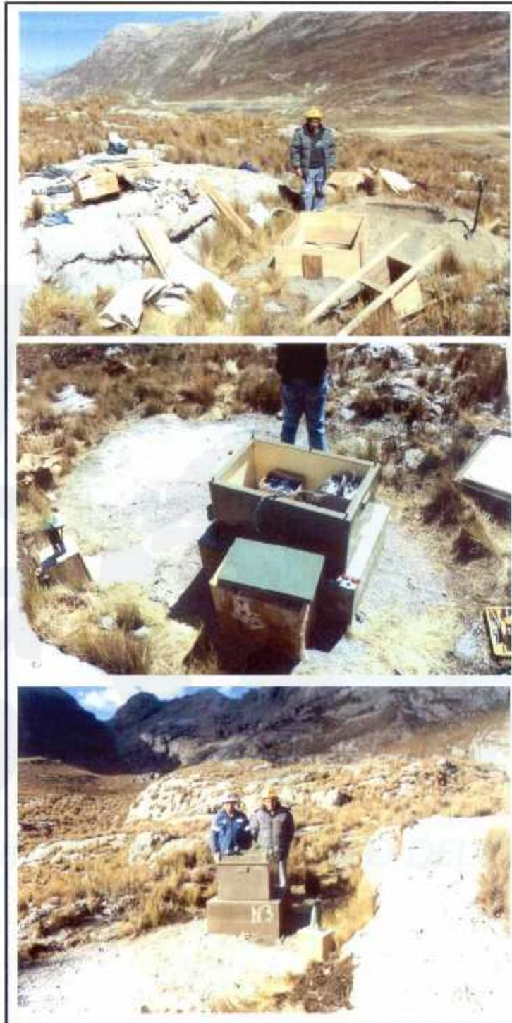
**Figura 6.** Fotos de la estación sísmica STA3. En la parte superior se observa los trabajos de logística seguidos para la construcción de las casetas, en el centro la disposición del sensor y sistema de registro, y en la parte inferior la estación sísmica en operación.
