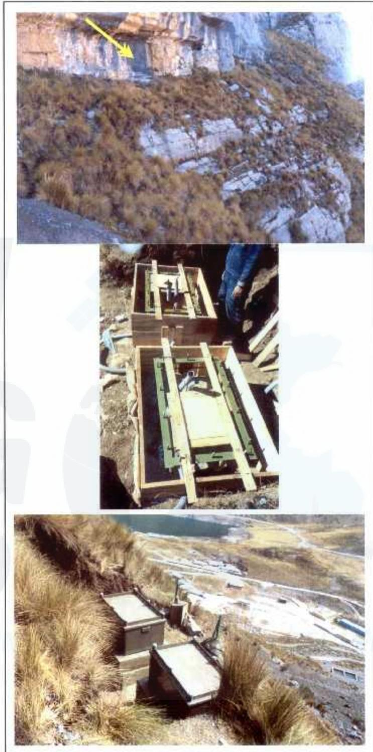
**Figura 4.** Imágenes que muestran la ubicación y las características de los equipos sísmicos instalados en la estación STA1: Sismógrafo y acelerómetro. La foto superior muestra el lugar en donde fueron ubicadas las estaciones, la foto del centro la construcción de las casetas sísmicas y la foto de abajo, las mismas estaciones en operatividad.
