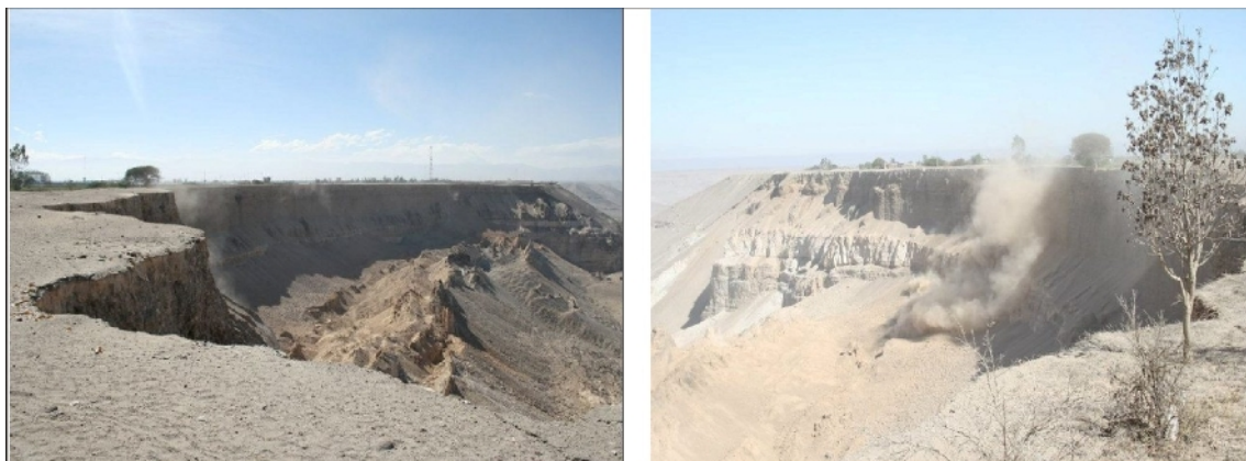
Figura 4.- Imágenes que muestran los efectos del sismo de Chuquibamba. Importantes deslizamientos producidos en San Juan El Alto de la localidad de Majes (Fuente: Diarios de Edición Nacional).
