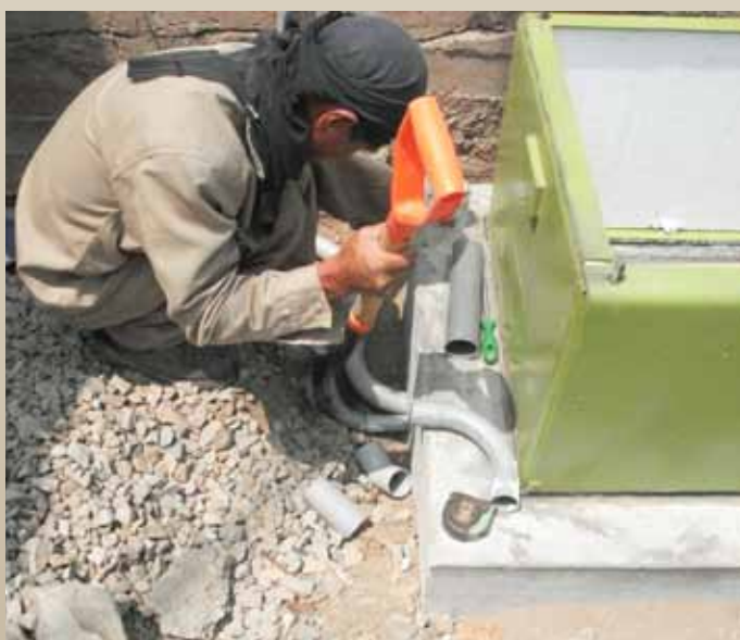
Acelerómetro instalado en el local del consejo de la Comunidad Autogestionaria de Huaycán
