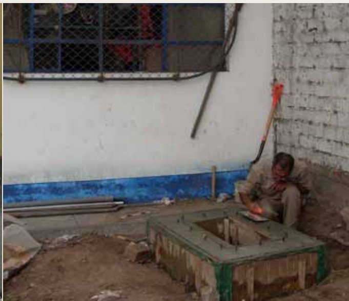
Acelerómetro instalado en el local de INDECI en Chaclacayo
