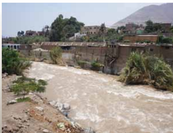
Viviendas ubicadas en el cauce del río Rimac
