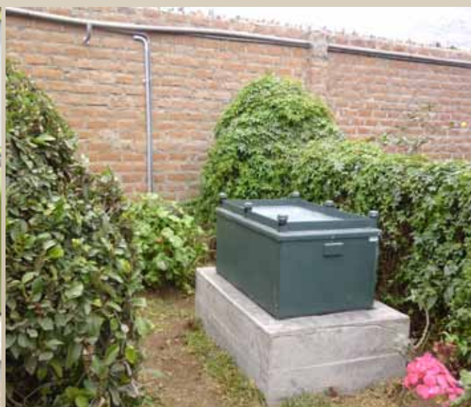
Acelerómetro instalado en la institución educativa Divina Sabiduría en Carapungo
