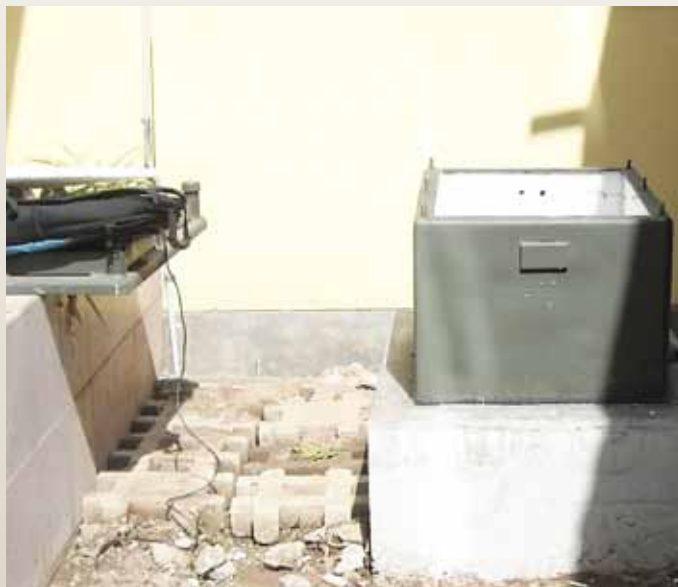
Acelerómetro instalado en la DEMUNA de Chosica
