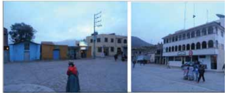
Figura 7. Viviendas de adobe, tapial y ladrillo en la plaza de armas de Cabanaconde que no fueron afectadas por el sismo de Huambo (Foto: J.C. Gomez)
