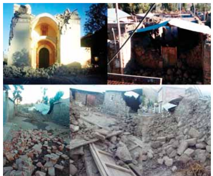
Figura 3. Imágenes de diversas viviendas Ichupampa, Yanque y Achoma construidas con adobe, sillar, piedras y ladrillo pandereta que colapsaron por la fuerte intensidad de sacudimiento del suelo debido al sismo de Ichupampa (fuentes RPP y Facebook valle del Colca).
